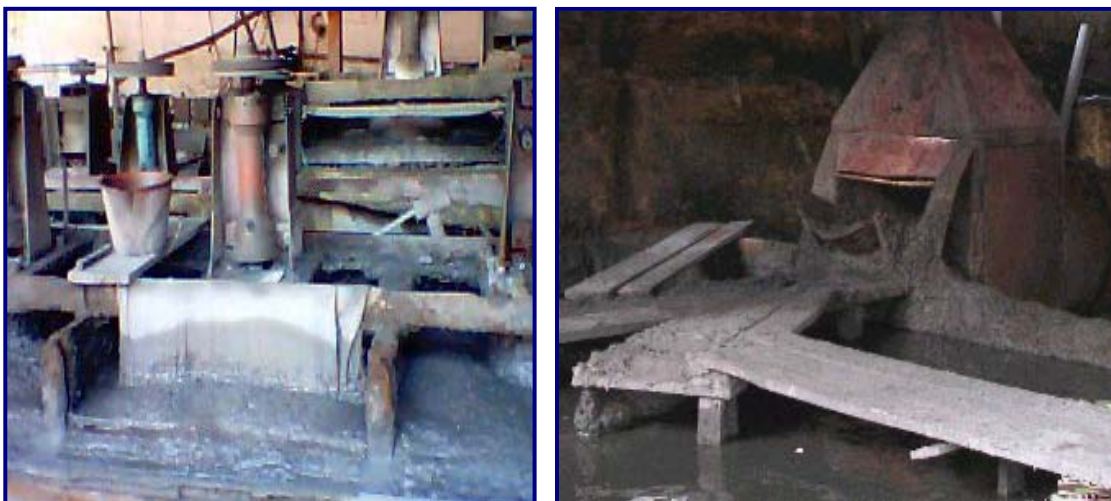
Figura 21. Celdas de Flotación de Plomo- Piscina de Plomo y Horno.
