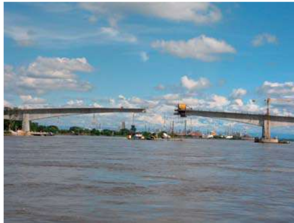
Figura 3. Puente Guillermo Gaviria Correa durante construcción. Tomado de (León & Suárez, 2007)
