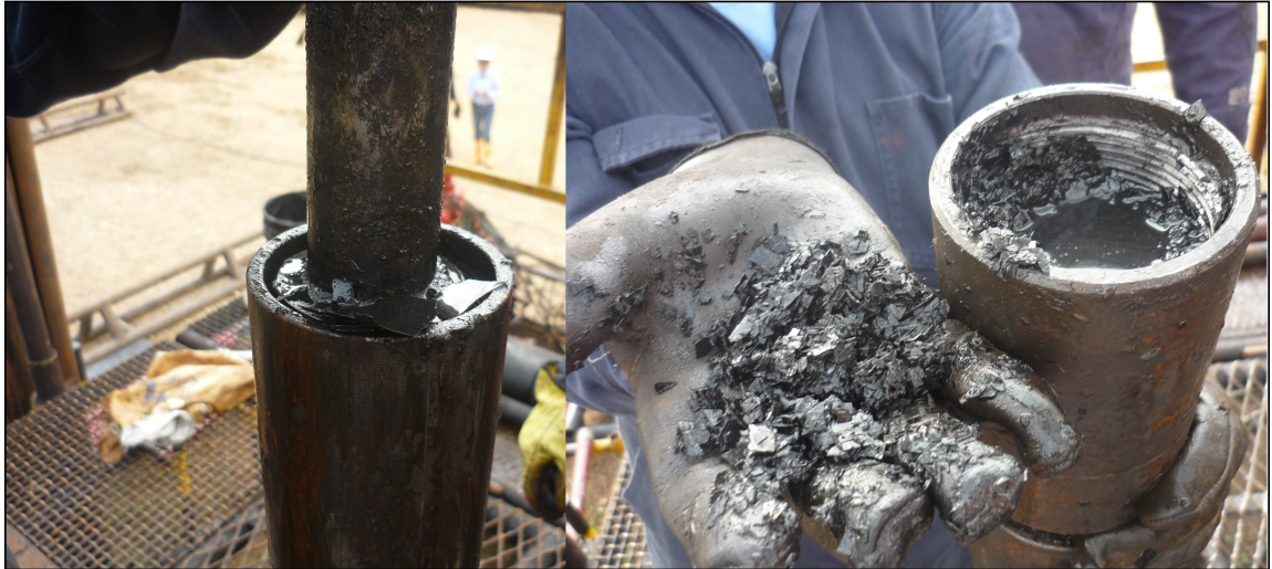
Figura 55. Taponamiento de bomba de chorro por escamas de corrosión
