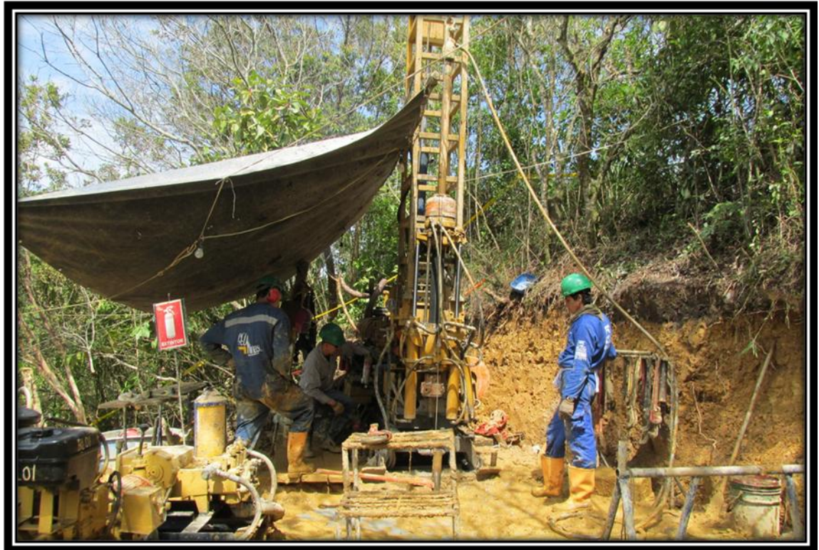
Figura 8. Plataforma de perforación con el personal operativo, realizando la labor de inspección de control.
