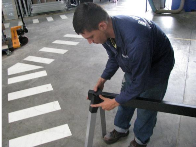
Figura 87. Alineación del primer pedestal con la viga.
