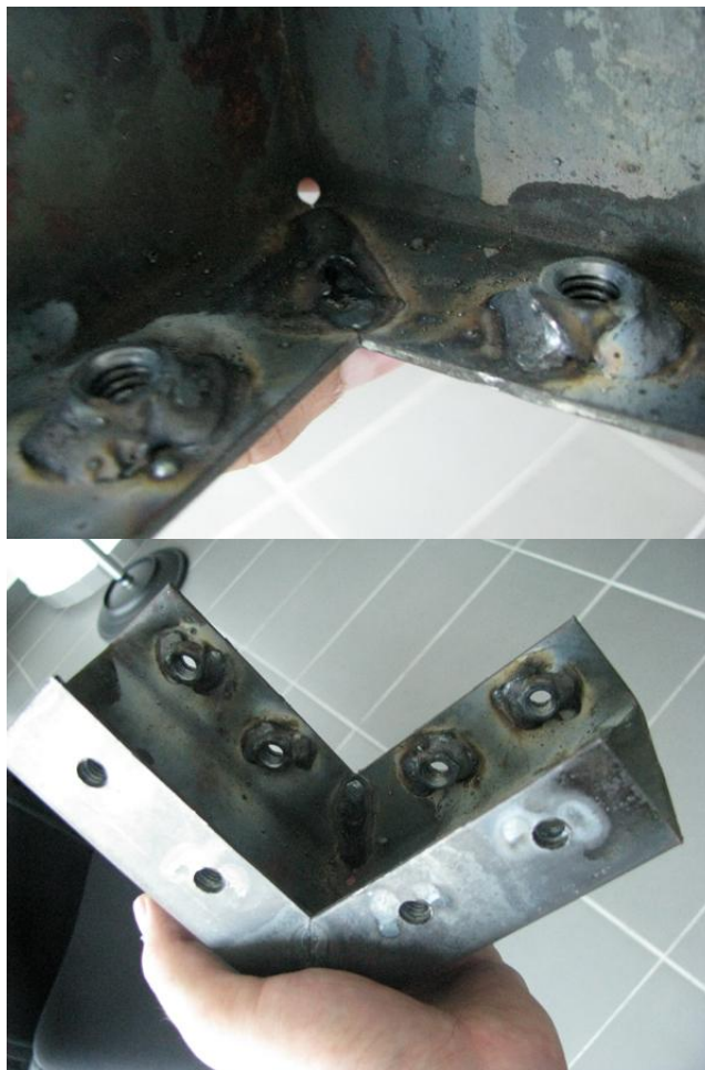
Figura 66. Soldadura del herraje de unión a 90° para vigas klass.
