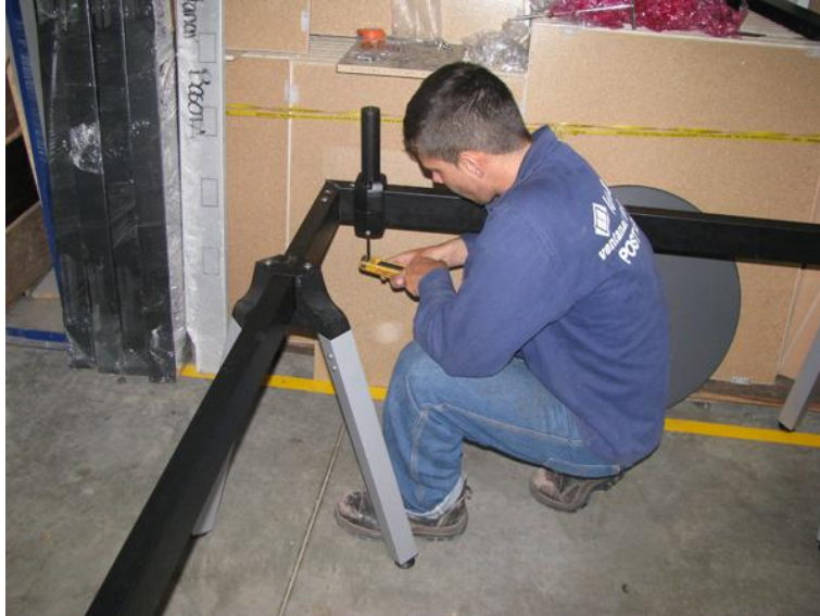
Figura 93. Instalación del dispositivo para superficie elevada en la viga.
