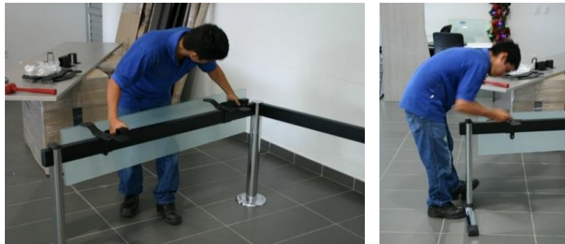
Figura 17: Instalación de la falda en un puesto de trabajo Klass.
