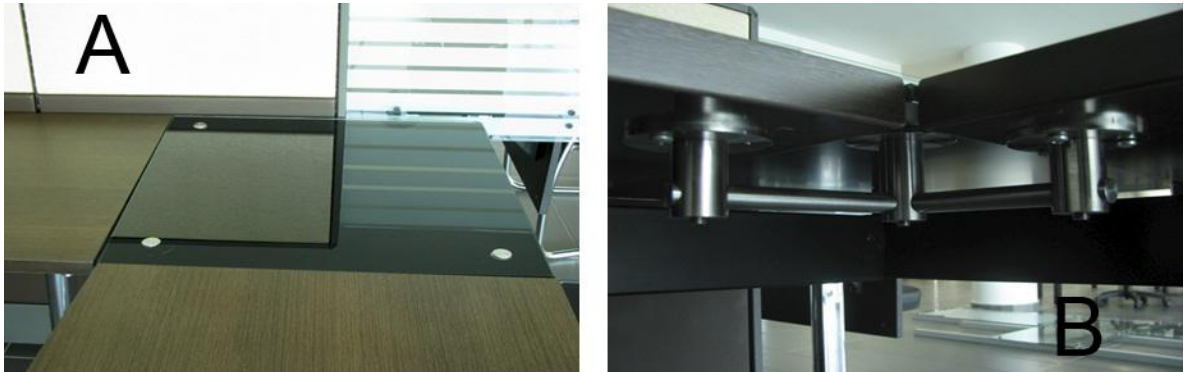
Figura 10. Figura 10: Accesorios de acero inoxidable: A. Superficie de vidrio unida a 2 superficies de madecor. B. Accesorio que sujeta las 3 superficies.
