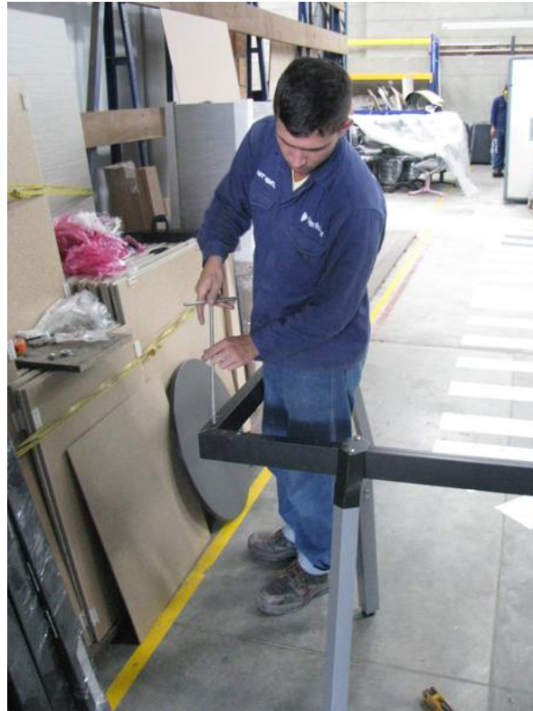
Figura 91. Ajuste de los tornillos en el herraje de unión a 90°.
