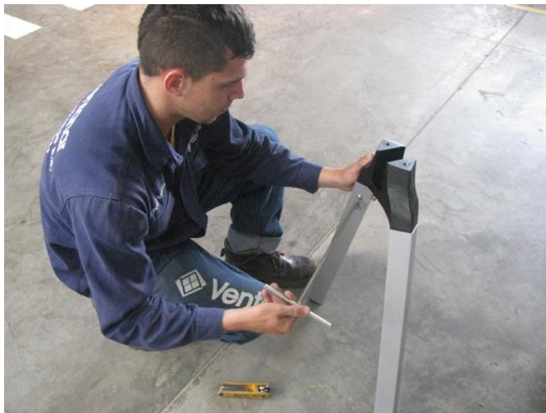
Figura 86. Ajuste de los parales con llave bristol.
