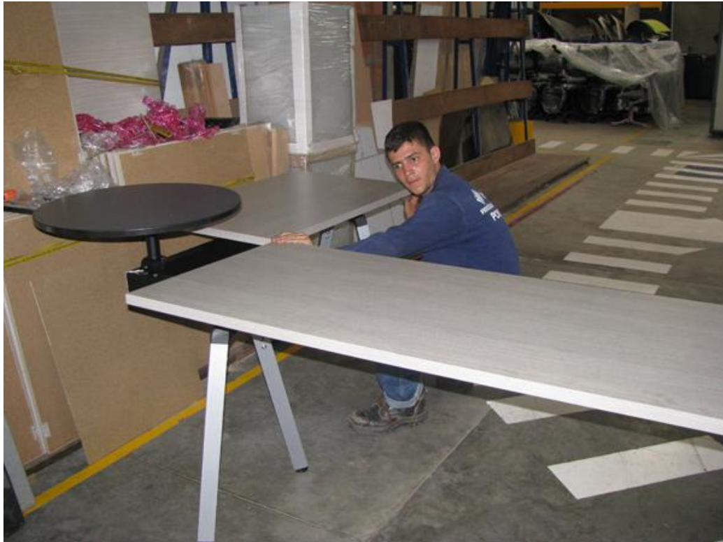
Figura 97. Instalación de las superficies de trabajo.
