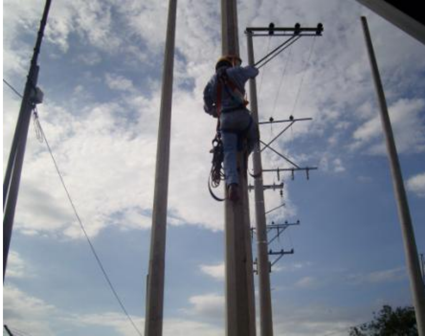
Ilustración 5. Trabajos Alturas Energía y Telecomunicaciones.
