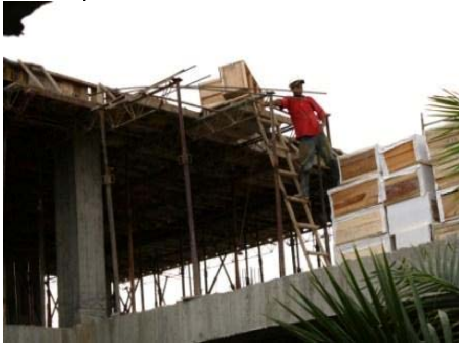
Ilustración 11. Trabajos Alturas Construcción.
