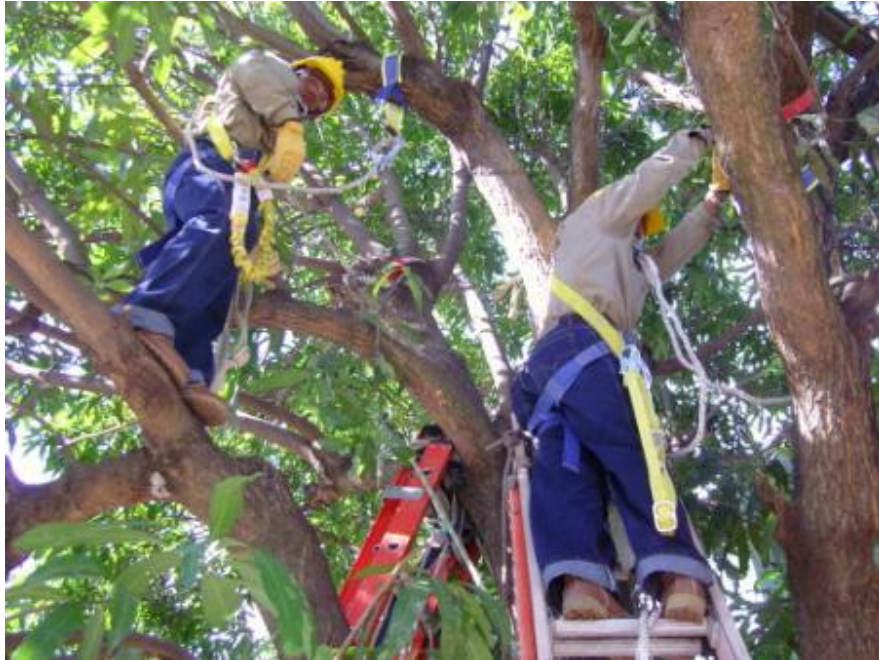
Ilustración 9. Trabajos Alturas Energía y Telecomunicaciones.
