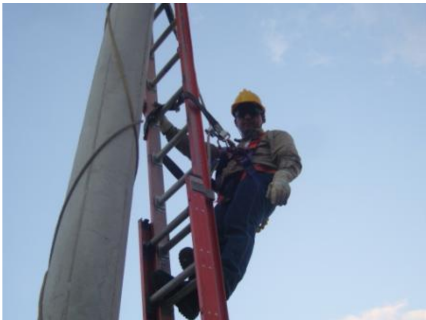
Ilustración 8. Trabajos Alturas Energía y Telecomunicaciones.
