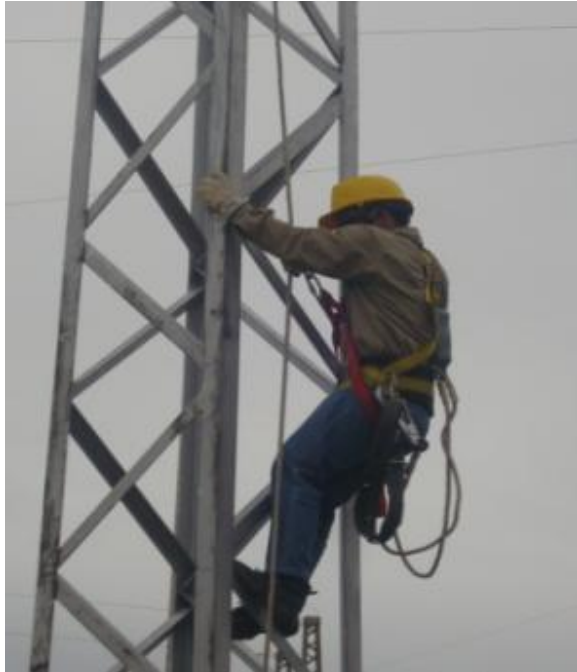
Ilustración 7. Trabajos Alturas Energía y Telecomunicaciones.
