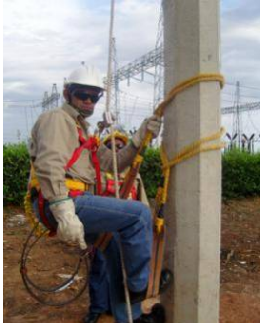
Ilustración 6. Trabajos Alturas Energía y Telecomunicaciones.
