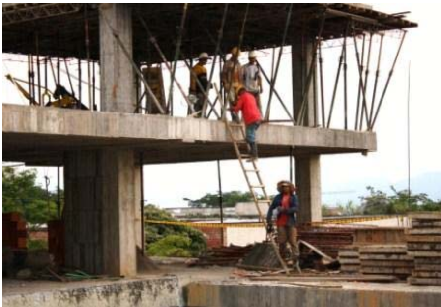
Ilustración 12. Trabajos Alturas Construcción.
