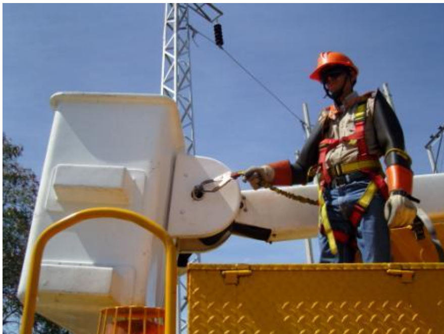
Ilustración 10. Trabajos Alturas Energía y Telecomunicaciones.
