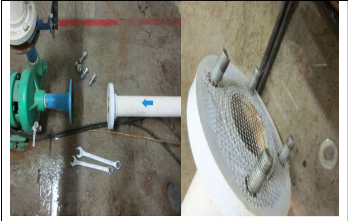
Imagen 7. Limpieza electro bomba.
