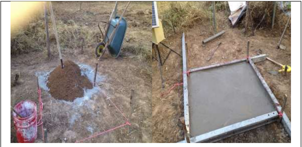
Imagen 15. Construcción base estación meteorológica.
