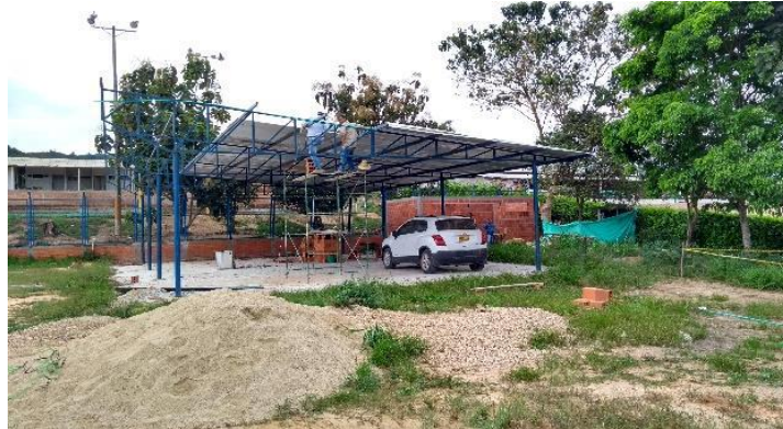
Figura 7 Instalación cubierta junto a la construcción de baños.
