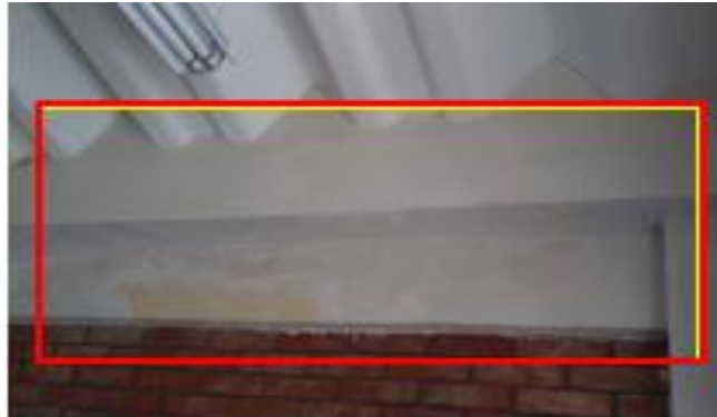
Figura 2 Resane y reparación de la humedad presente en la viga canal.
