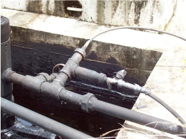
Figura 9. Fotografía Pozo Cira 1173
