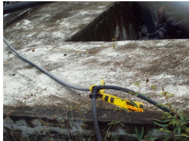
Figura 7. Fotografía Pozo Cira 0297
