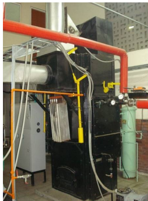
Figura 4. Sobrecalentador-Economizador
