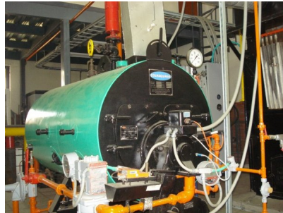
Figura 2. Caldera pirotubular (Distral)
