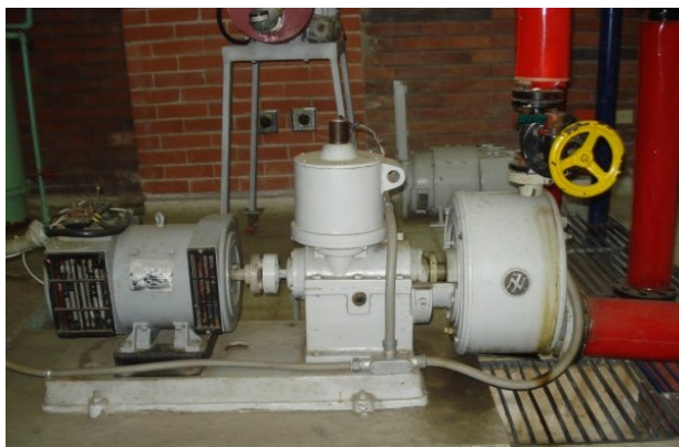
Figura 10. Turbina de impulso.
