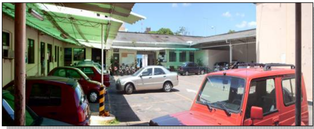
Figura 4. Edificio de Redes
