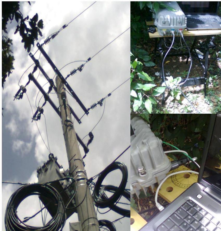
Figura 31. Imagen de la instalación del enlace de PLC para las Pruebas en Línea Viva.
