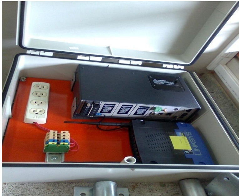
Figura 59. Imagen del montaje de las cajas para la implementación de PLC al proyecto SITELRED.
