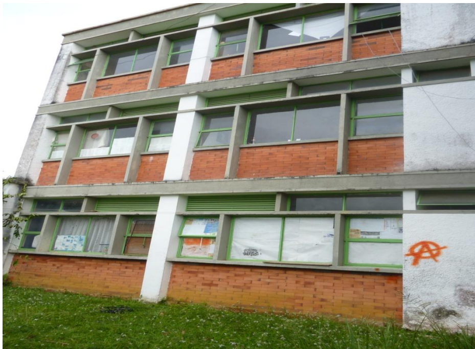
Fotografía 3. Detalle estructura parte frontal
