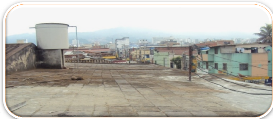
Foto 1. Tanque de agua potable
