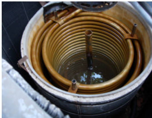
Figura 7. Evaporador de la unidad ROBUR.
