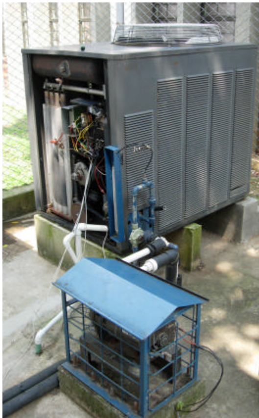
Figura 1. Unidad enfriadora ROBUR modelo ACC 60 – 00.
