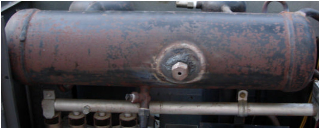
Figura 58. Termo pozo adaptado a la cámara de nivelación.
