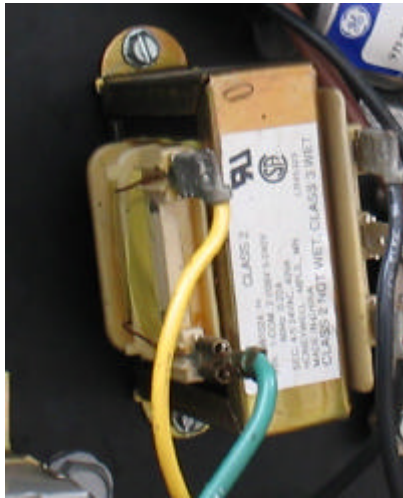
Figura 20. Transformador 220 / 24 V
