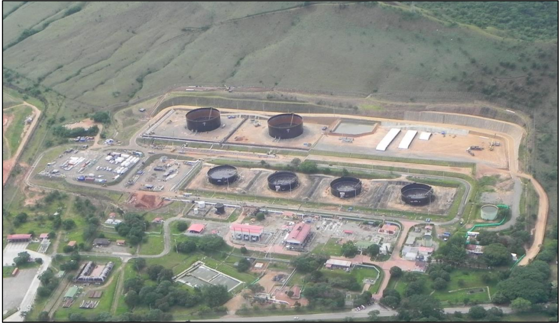
Figura 1. Vista aérea de la Planta Araguane 1
