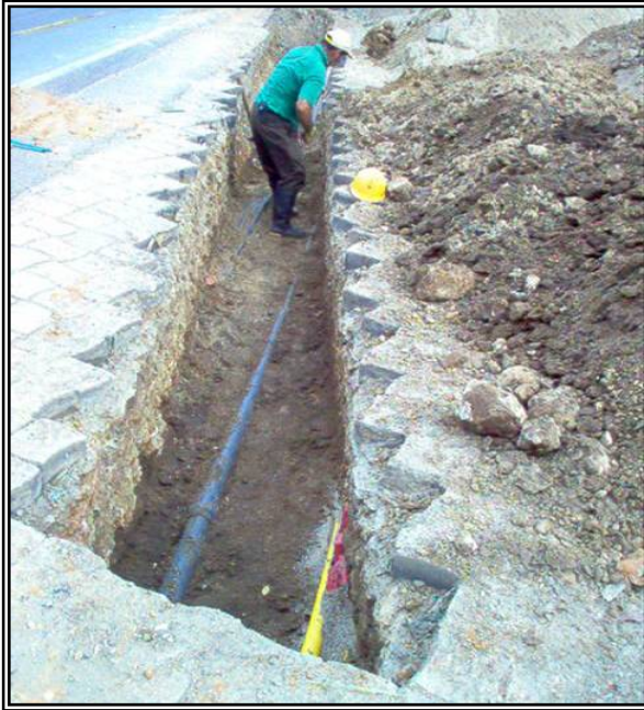
Figura 33. Proceso De Excavación Manual En Adoquín, Contrato No. 5121 – 01.
