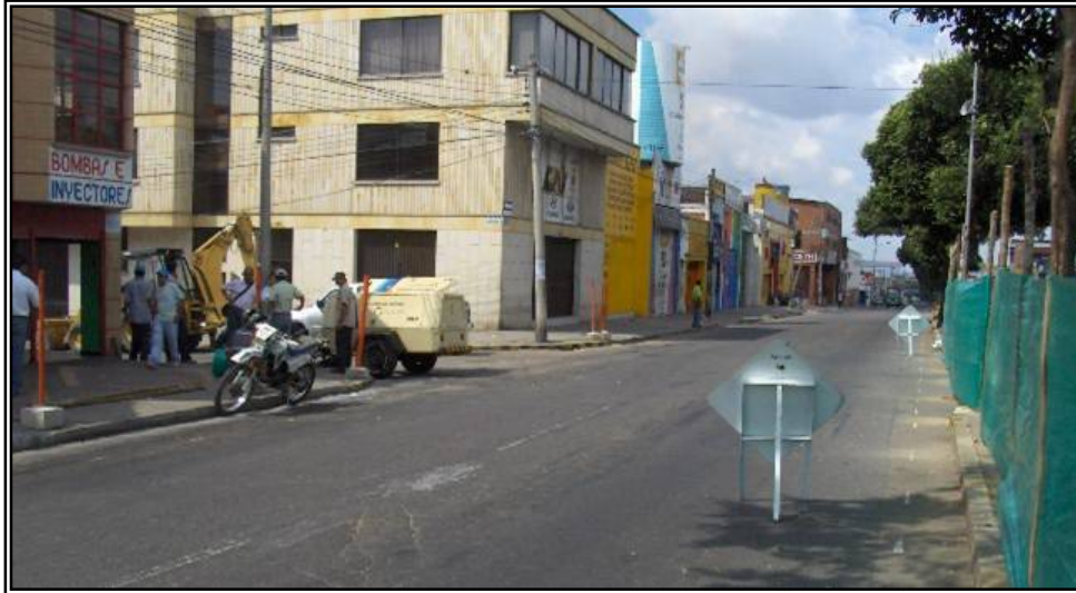
Figura 90. Punto De Inicio De Las Obras Cra 15 – Cll 16, Contrato No. 5368 – 01.
