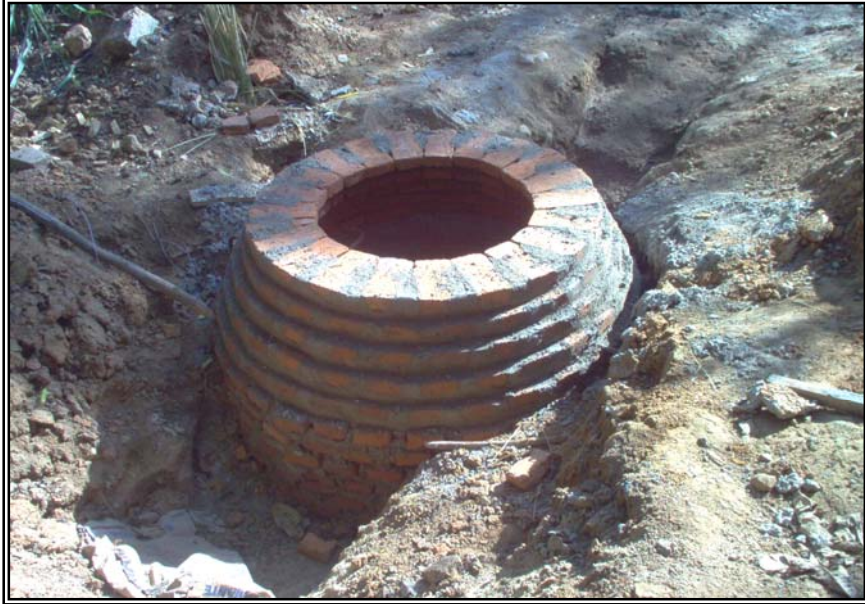
Figura 52. Reducción En Mampostería; Pozo P(ILC) R54, Contrato No. 5121 – 01.
