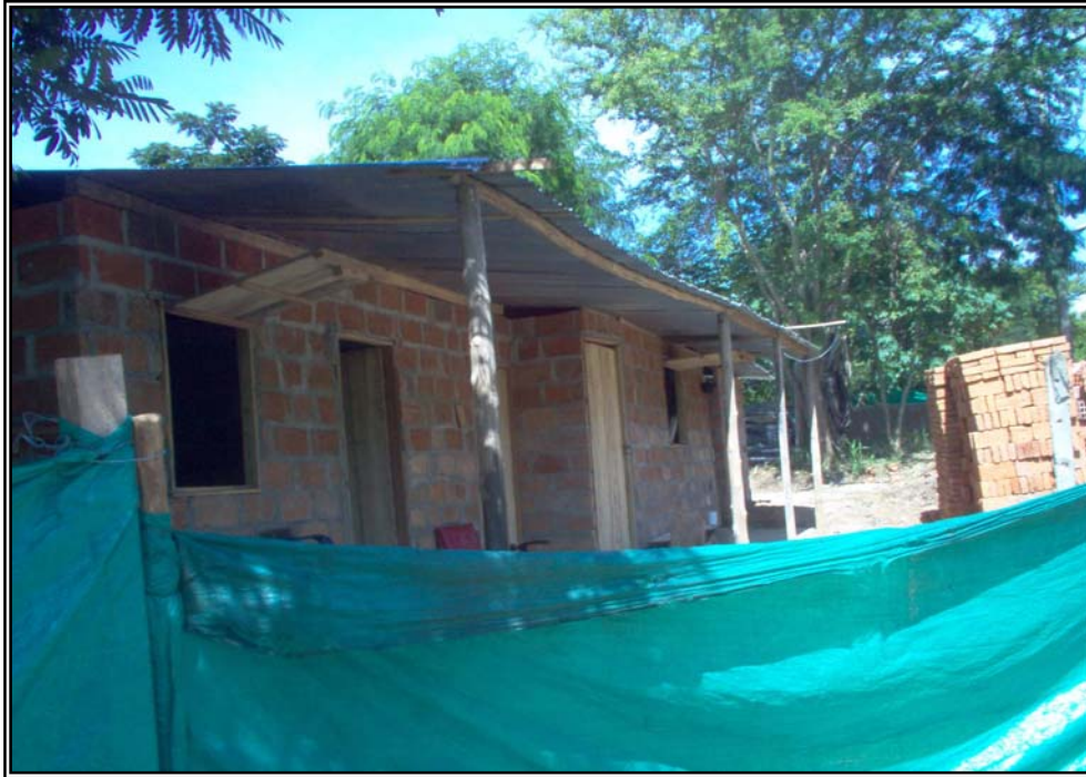
Figura 19. Vista Del Campamento Construido, Contrato No. 5121 – 01.
