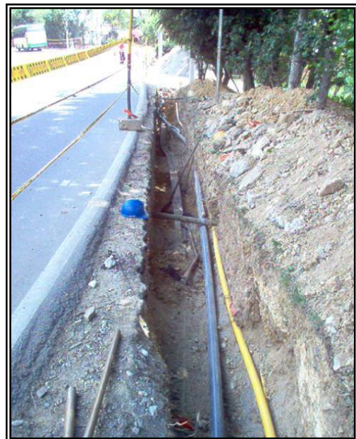
Figuras 34 y 35. Proceso De Excavación Manual – Berma, Contrato No. 5121 – 01.
