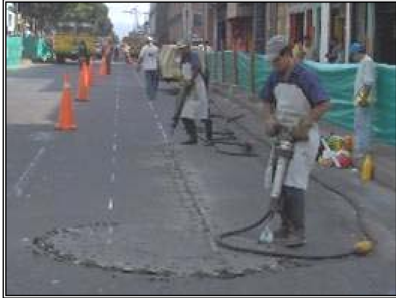
Figura 92. Rotura De Pavimento - Compresor Y Martillos Demoledores, Contrato No. 5368 – 01.
