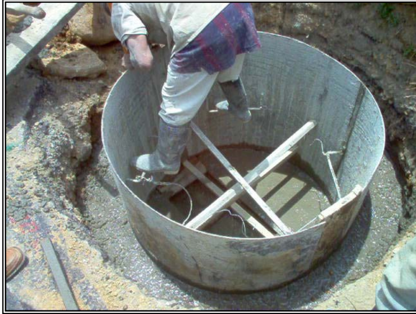
Figura 48. Formaleta Para Cilindro En Concreto De Pozo, Contrato No. 5121 – 01.
