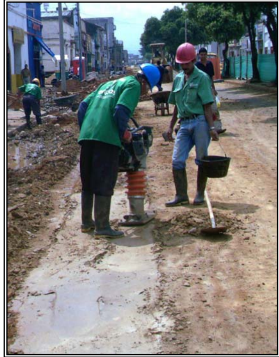
Figuras 108 y 109. Compactación De Relleno Empleando El Saltarín, Contrato No. 5368 – 01.
