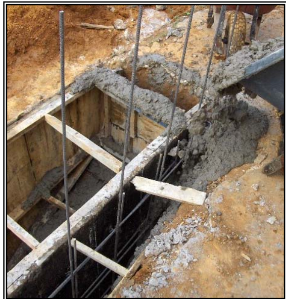
Figuras 110 y 111. Formaleta Y Fundición De Paredes De Sumideros, Contrato No. 5368 – 01.
