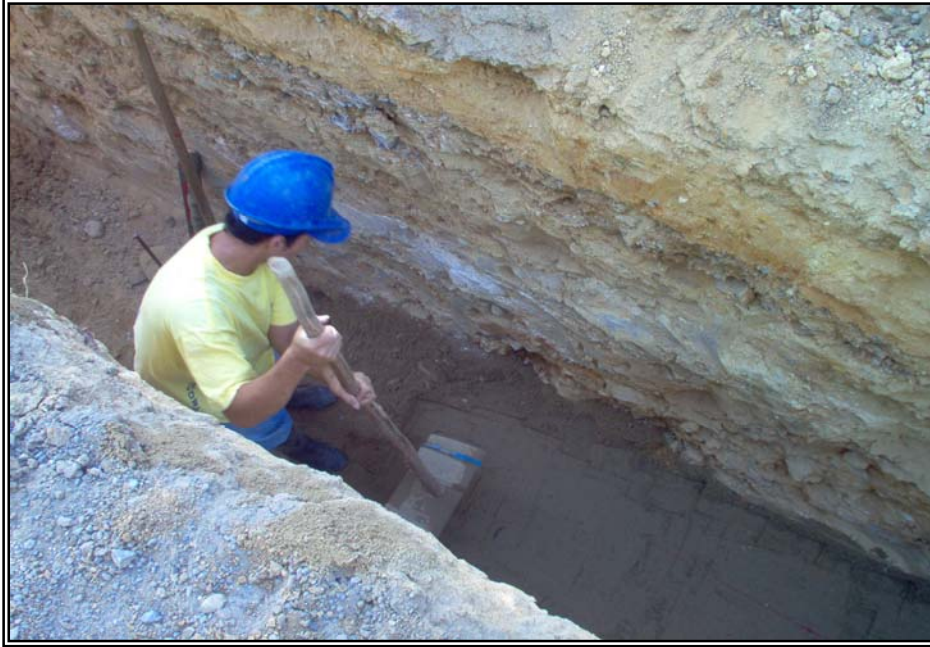
Figura 36. Apisonamiento De La Arena De Cimentación Tubería, Contrato No. 5121 – 01.
