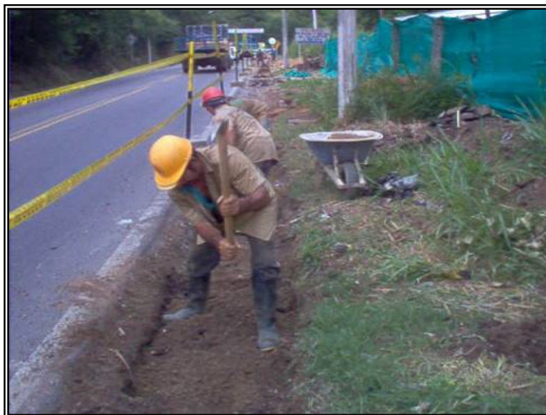
Figura 30. Proceso De Excavación Manual-Berma, Contrato No. 5121 – 01.
