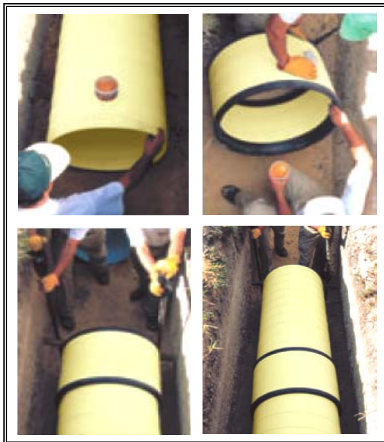
Figura 129. Secuencia De Unión Tubería PVC NOVALOC.
