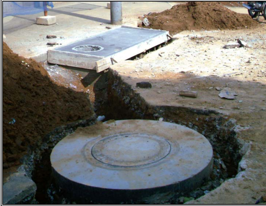
Figura 121. Pozo De Inspección Y Sumidero Terminados, Contrato No. 5368 – 01.
