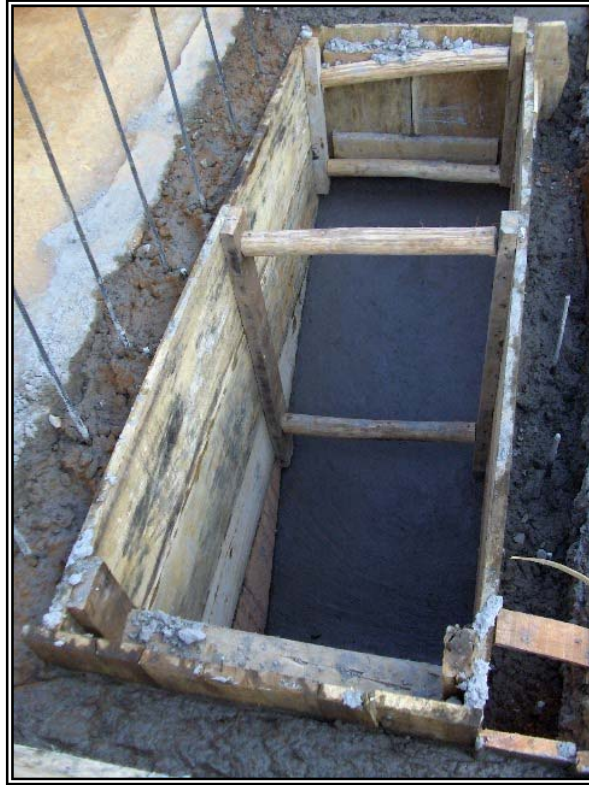
Figura 112. Paredes Y Piso De Sumidero Recién Fundidos, Contrato No. 5368 – 01.
