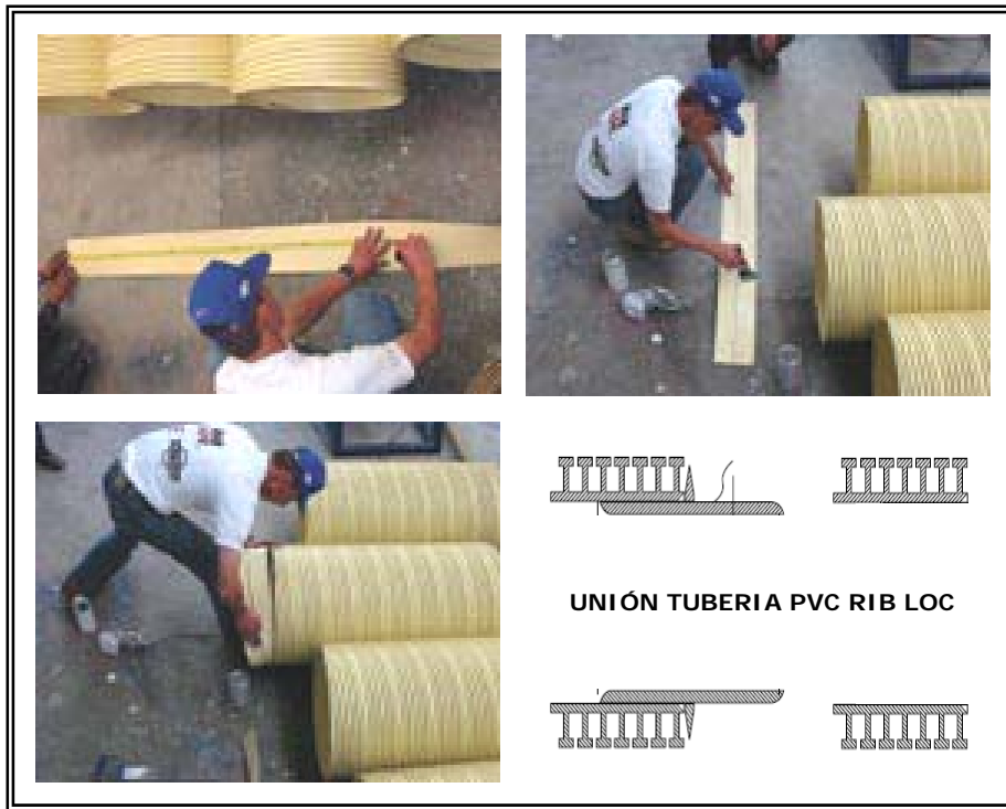
Figura 126. Secuencia De Unión Tubería PVC RIB LOC.
