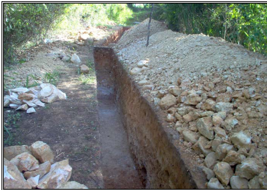
Figura 26. Zanja Excavada Manualmente, Contrato No. 5121 – 01.
