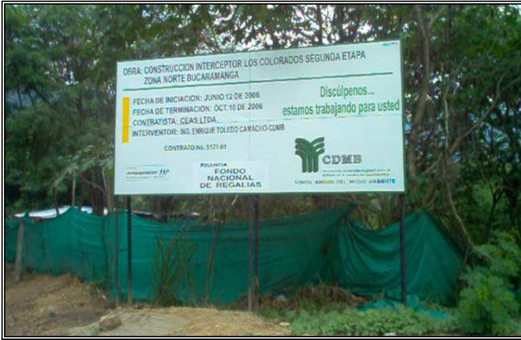
Figura 17. Valla Informativa del Proyecto, Contrato No. 5121 – 01.
