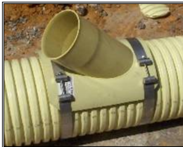
Figuras 100 a 104. Instalación Silla Ye Domiciliarias - NOVAFORT, Contrato No. 5368 – 01.
