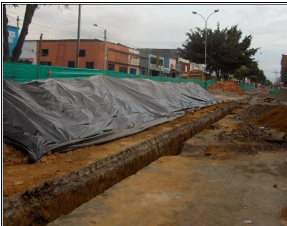
Figura 99. Zona Durante La Intervención, Contrato No. 5368 – 01.
