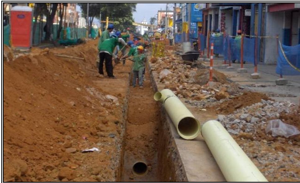
Figura 107. Relleno Con Material Común, Contrato No. 5368 – 01.
