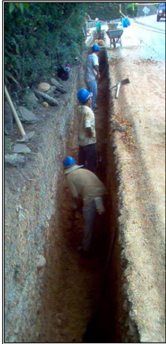
Tramo entre los pozos P(ILC) R27 y P(ILC) R26.
