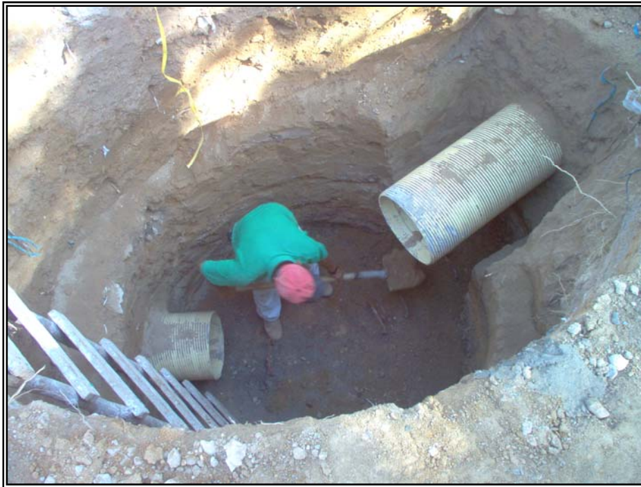
Figura 47. Excavación Manual Sifón De Caída Pozo, Contrato No. 5121 – 01.
