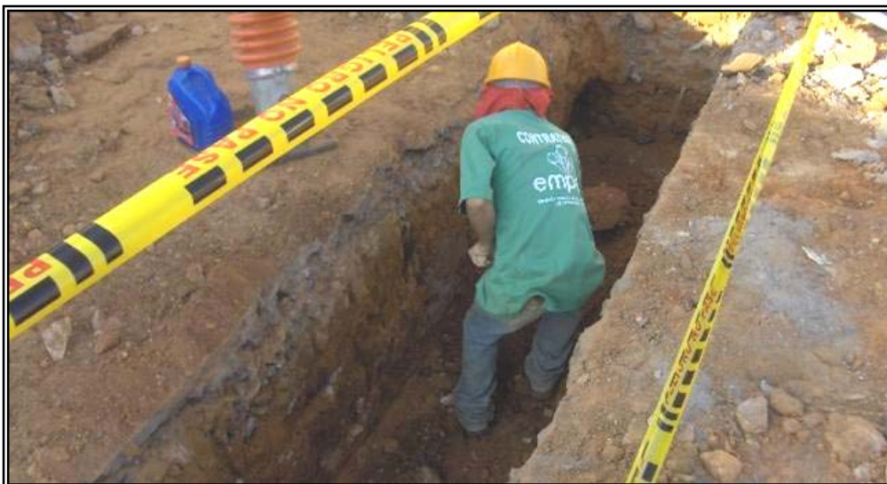
Figura 95. Excavación Manual, Contrato No. 5368 – 01.
