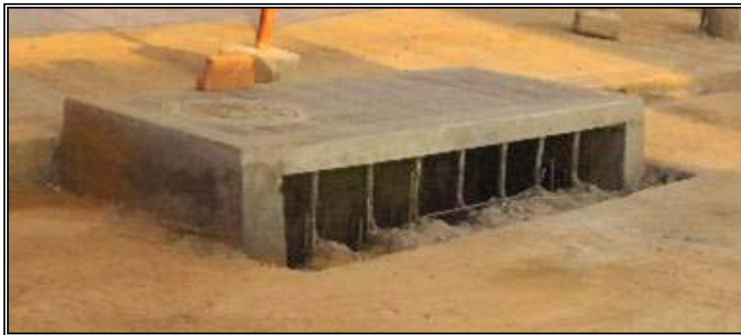
Figura 115. Sumidero Terminado, Contrato No. 5368 – 01.
