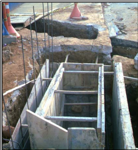
Figuras 110 y 111. Formaleta Y Fundición De Paredes De Sumideros, Contrato No. 5368 – 01.
