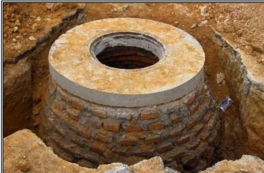
Figura 120. Pozo De Inspección Con Corona Instalada, Contrato No. 5368 – 01.
