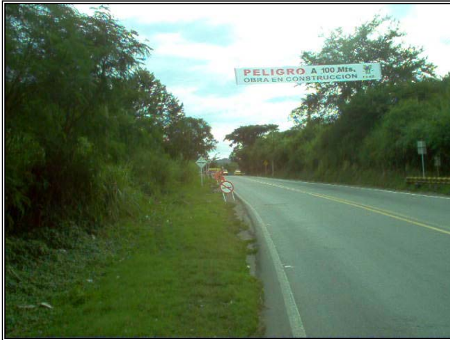
Figura 56. Señalización; Pasacalle De Aviso A 200m, Contrato No. 5121 – 01.
