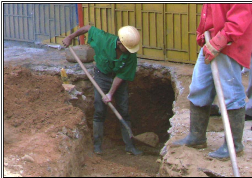
Figura 97. Excavación Manual Domiciliarias, Contrato No. 5368 – 01.
