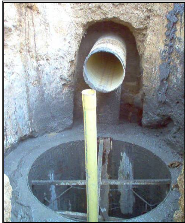
Figura 49. Cilindro En Concreto De Pozo Fundido, Contrato No. 5121 – 01.
