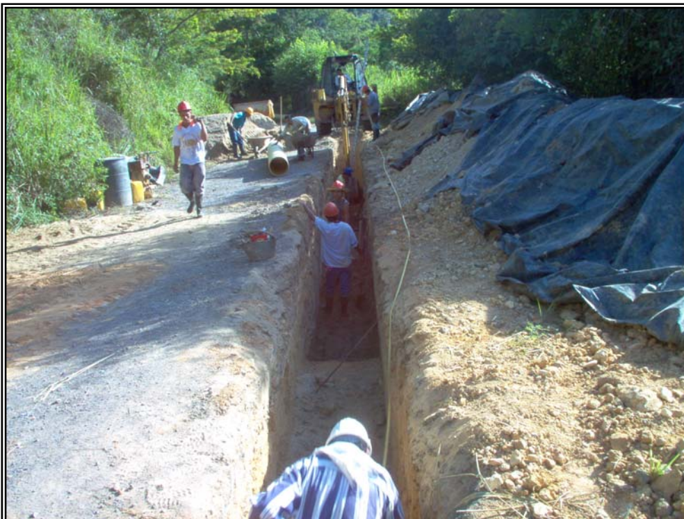
Figuras 27 y 28. Proceso De Excavación A Máquina, Contrato No. 5121 – 01.
