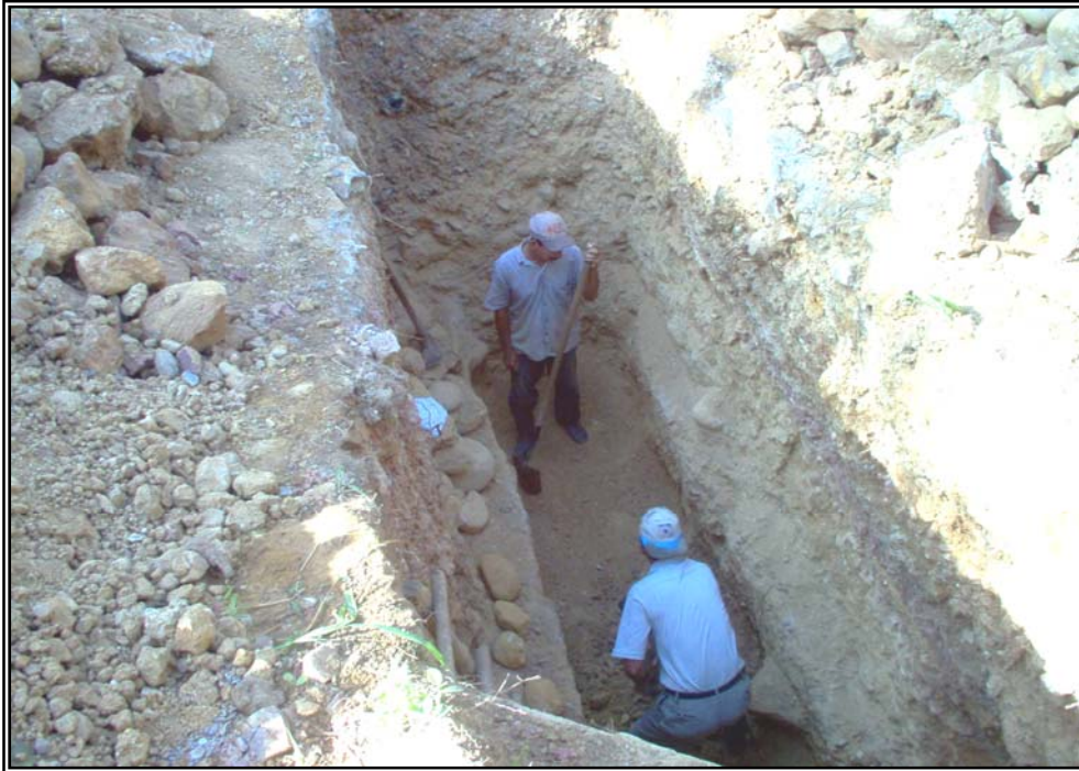
Figura 23. Proceso de Excavación Manual, Contrato No. 5121 – 01.
