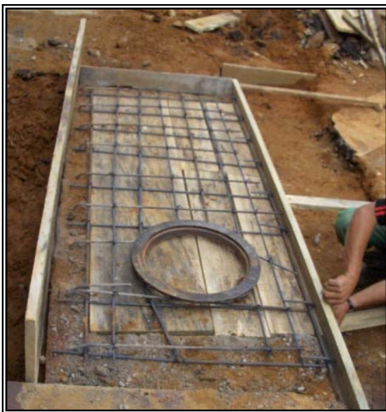
Figuras 113 y 114. Formaleta Y Fundición De Loza De Sumideros, Contrato No. 5368 – 01.
