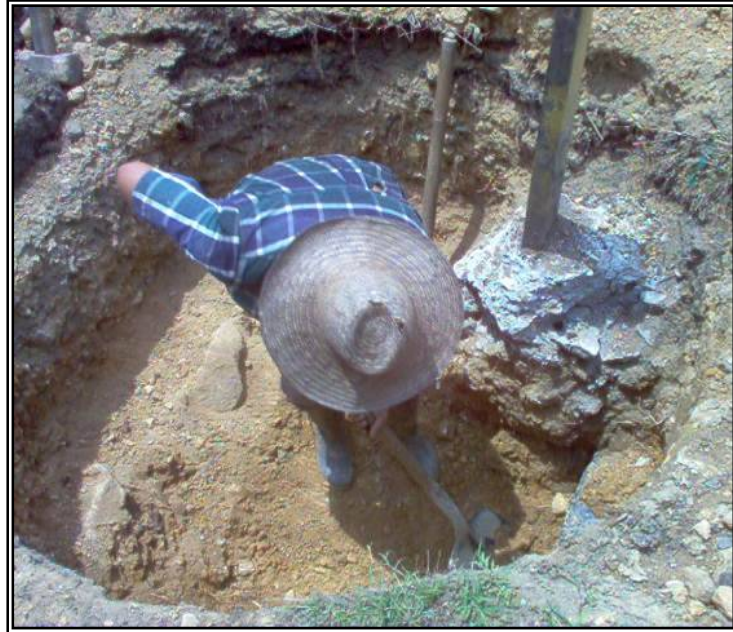
Figura 46. Excavación Manual De Pozos, Contrato No. 5121 – 01.
