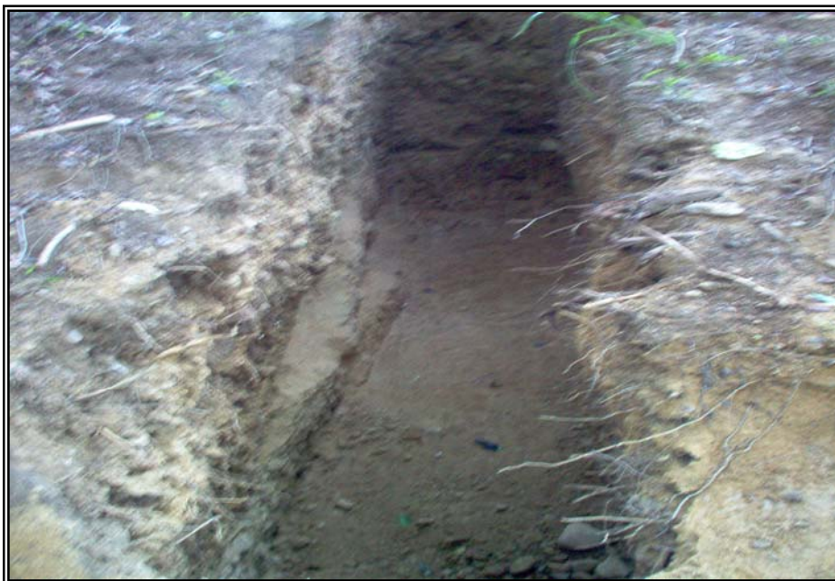
Figura 24. Zanja Excavada Manualmente, Contrato No. 5121 – 01.
