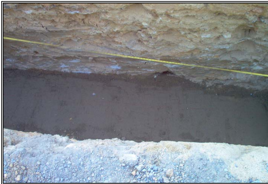
Figura 37. Cimentación De Tubería Terminada, Contrato No. 5121 – 01.
