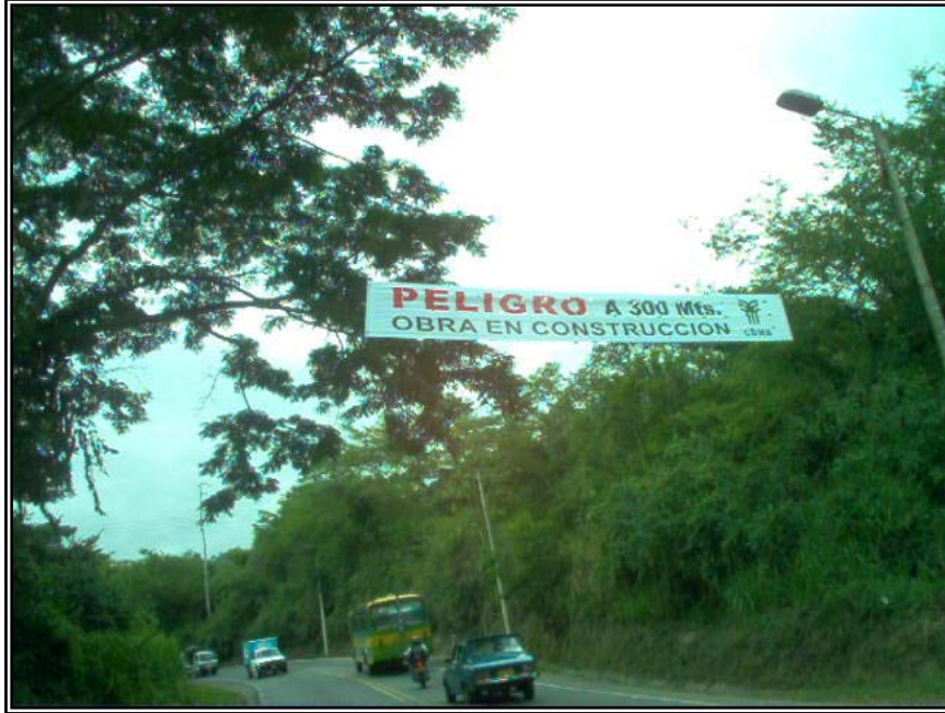
Figura 54. Señalización; Pasacalle De Aviso A 300m, Contrato No. 5121 – 01.
