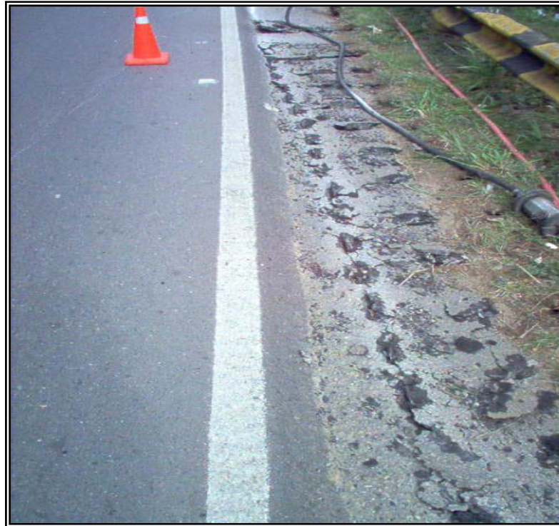
Figura 29. Demolición De Pavimento-Berma, Contrato No. 5121 – 01.
