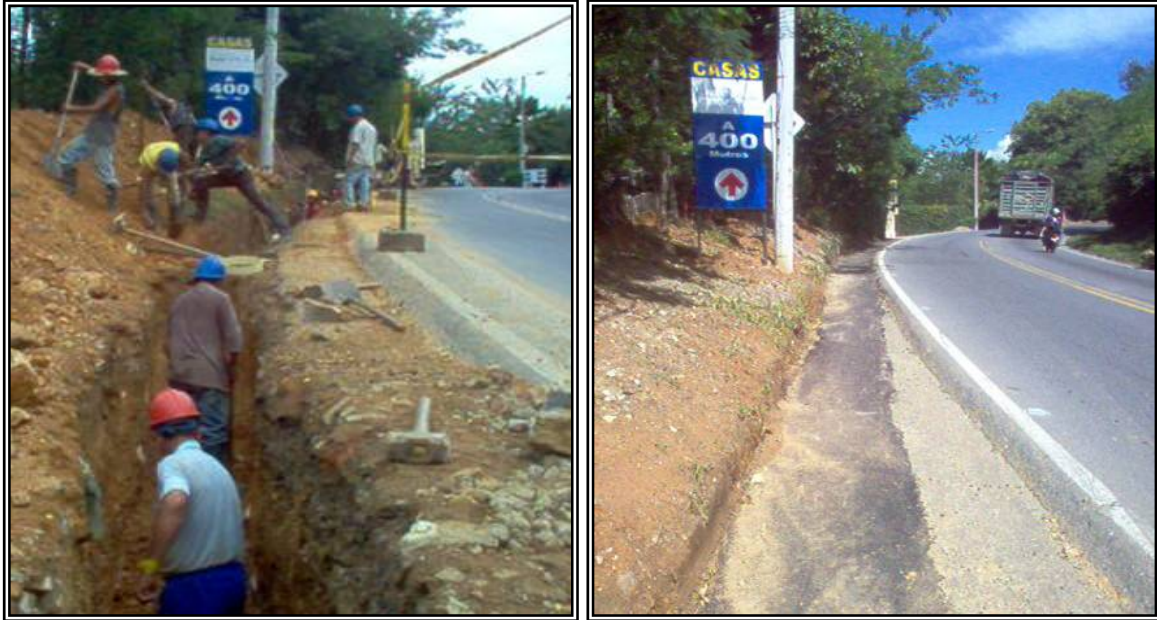
Tramo entre los pozos P(ILC) R29 y P(ILC) R27
