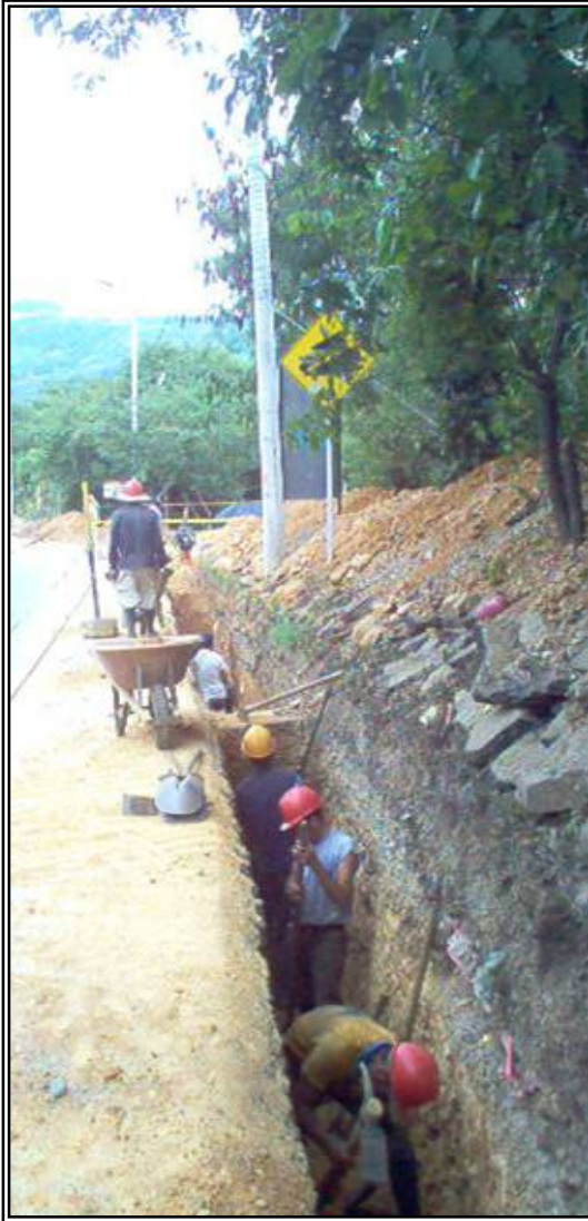
Tramo entre los pozos P(ILC) R27 y P(ILC) R28.
