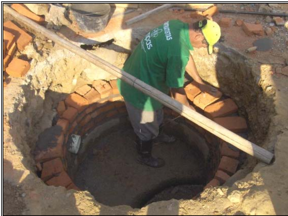
Figura 117. Mampostería Pozo De Inspección, Contrato No. 5368 – 01.
