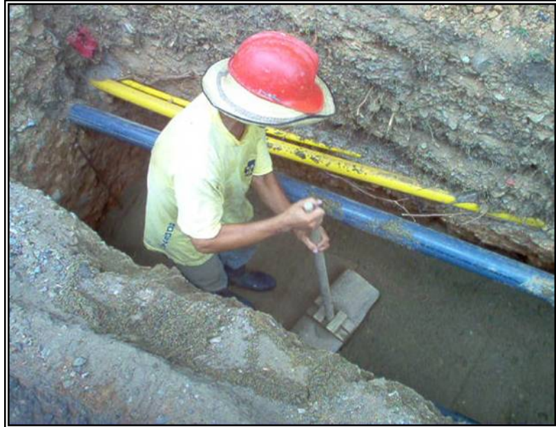
Figura 43. Apisonamiento Capa De Arena Sobre La Tubería, Contrato No. 5121 – 01.
