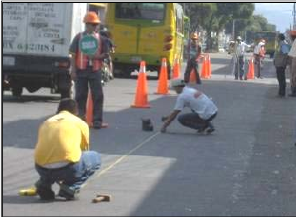
Figura 91. Replanteo Preliminar, Contrato No. 5368 – 01.
