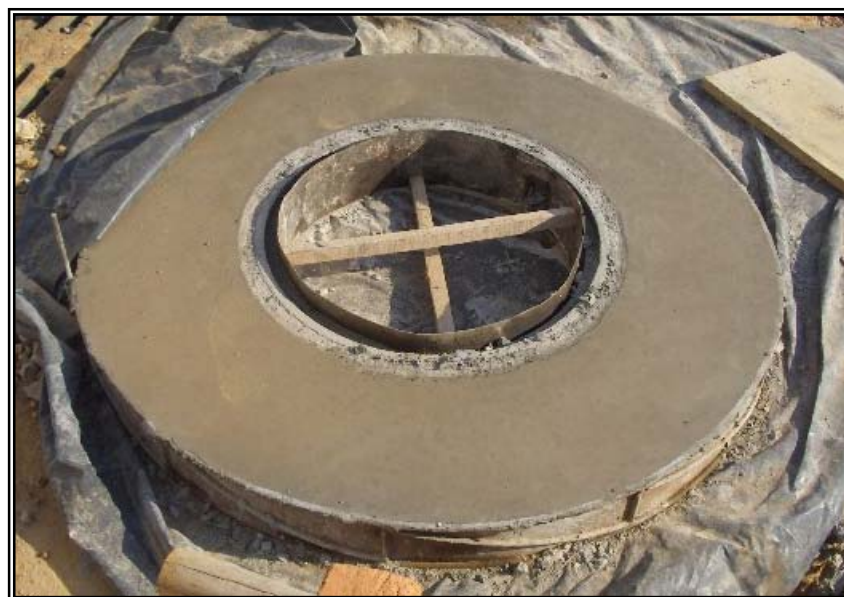
Figura 118. Corona De Pozo Fundida Aparte Para Posterior Instalación, Contrato No. 5368 – 01.
