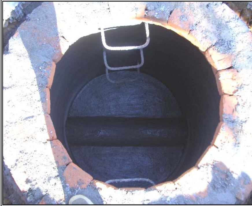
Figura 119. Interior Pozo De Inspección, Contrato No. 5368 – 01.
