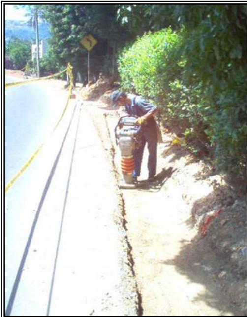
Figuras 44 y 45. Compactación Final Mediante El Uso Del Saltarín, Contrato No. 5121 – 01.
