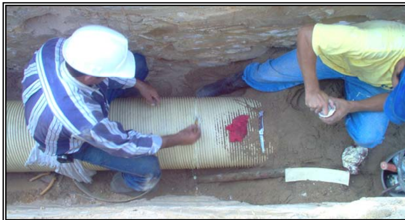
Figuras 38 a 42. Secuencia De Instalación De La Tubería Rib Loc 400mm, Contrato No. 5121 – 01.
