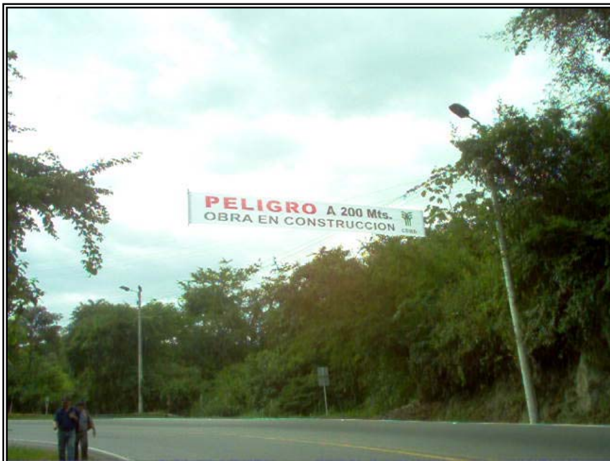
Figura 55. Señalización; Pasacalle De Aviso A 200m, Contrato No. 5121 – 01.
