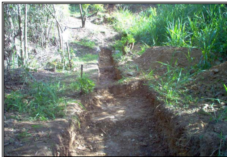
Figura 22. Inicio De Excavaciones, Contrato No. 5121 – 01.
