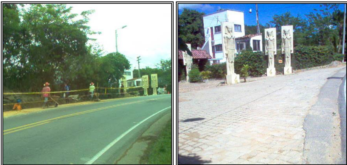
Tramo entre los pozos P(ILC) R27 y P(ILC) R26
