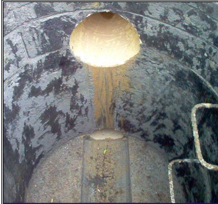
Figura 50. Vista Interior Pozo, Contrato No. 5121 – 01.
