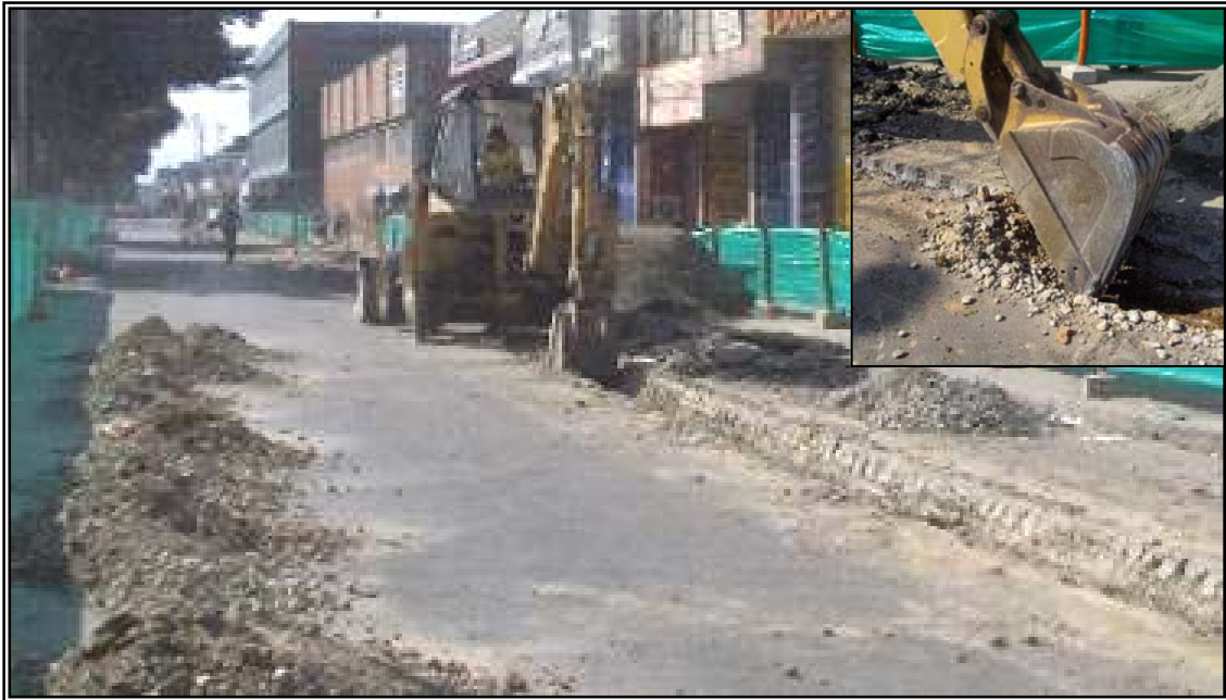
Figura 93. Retiro De Capa Asfáltica – Retrocargador CAT 428B, Contrato No. 5368 – 01.
