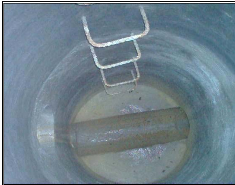
Figura 51. Vista Interior Pozo, Contrato No. 5121 – 01.
