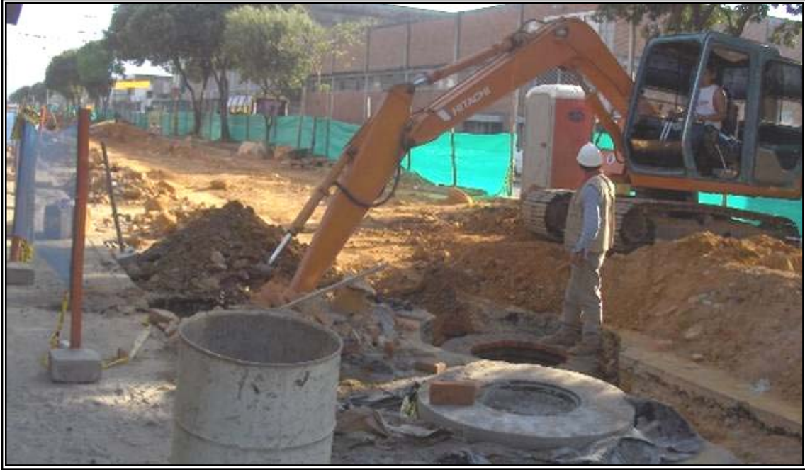
Figura 96. Excavación Domiciliarias - Excavadora HITACHI ZX130, Contrato No. 5368 – 01.
