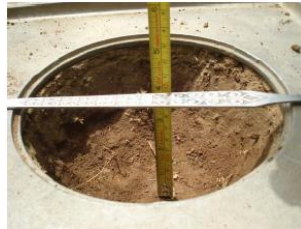
Figura 237. Excavar un agujero de 10cm de profundidad.
