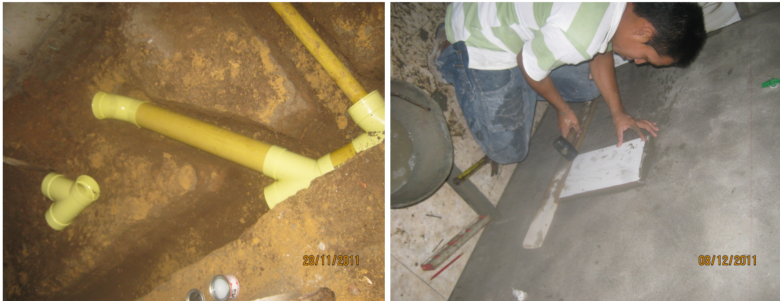
Figura 26.Red sanitaria y enchape, mejoramiento 11
