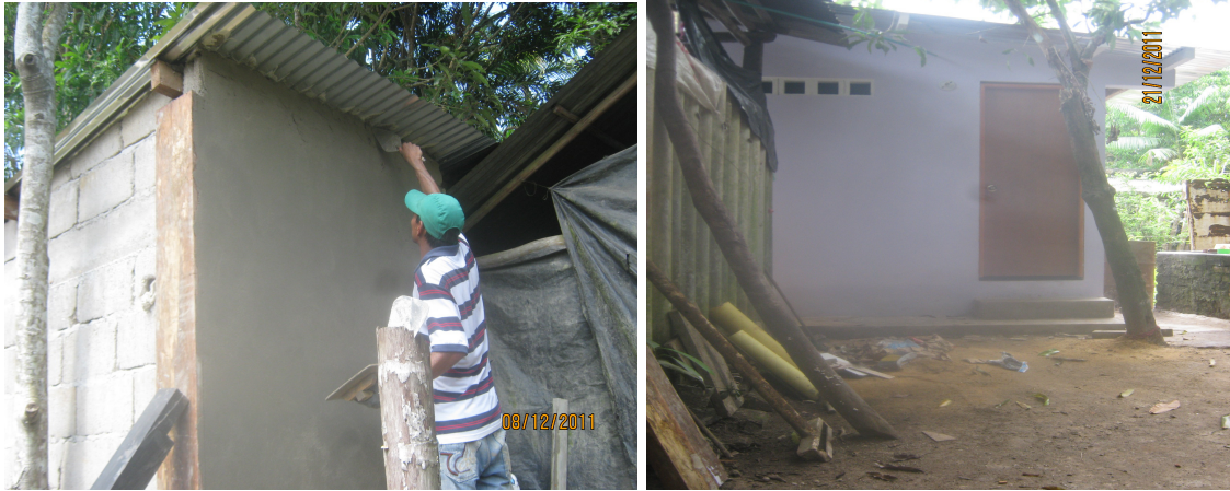
Figura 29. Pañete y obra terminada, mejoramiento 12
