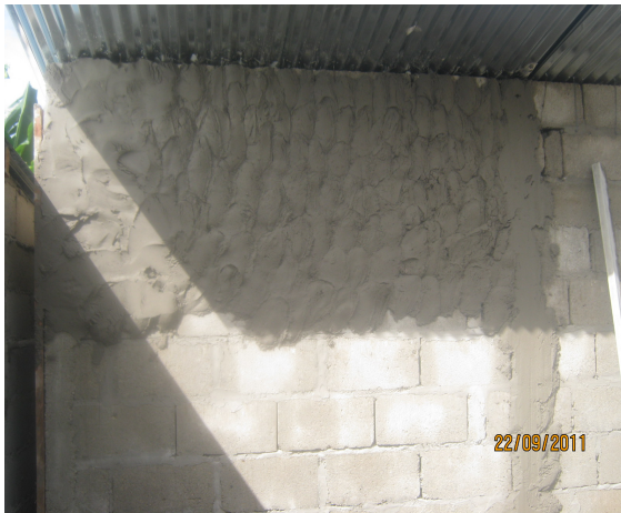
Figura 8. Pañete y enchape, mejoramiento 2
