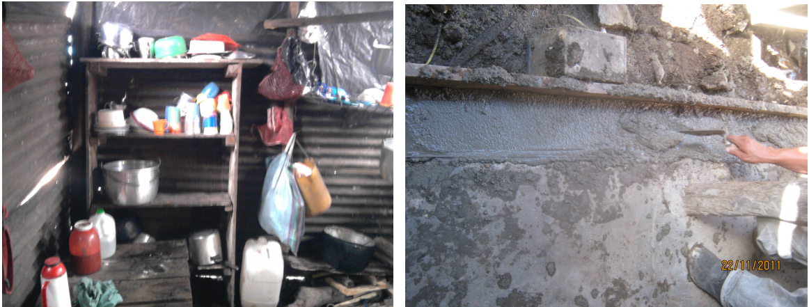
Figura 30. Visita preliminar y viga de cimentación, mejoramiento 13
