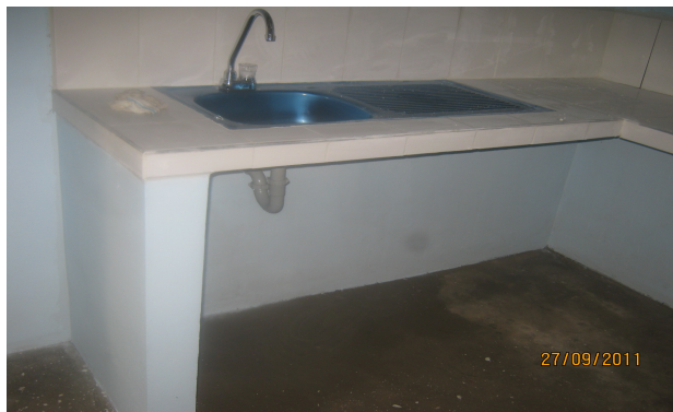
Figura 6. Obra terminada, Mejoramiento 1
