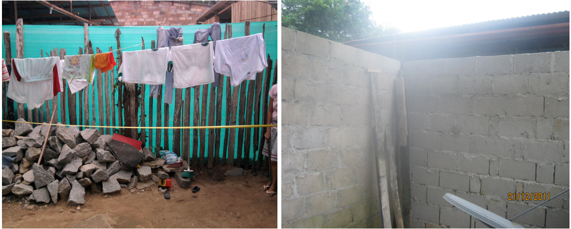
Figura 35. Visita preliminar y muros, mejoramiento 15
