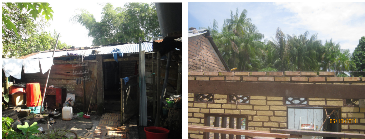
Figura 13. Visita preliminar y desmonte, mejoramiento 5
