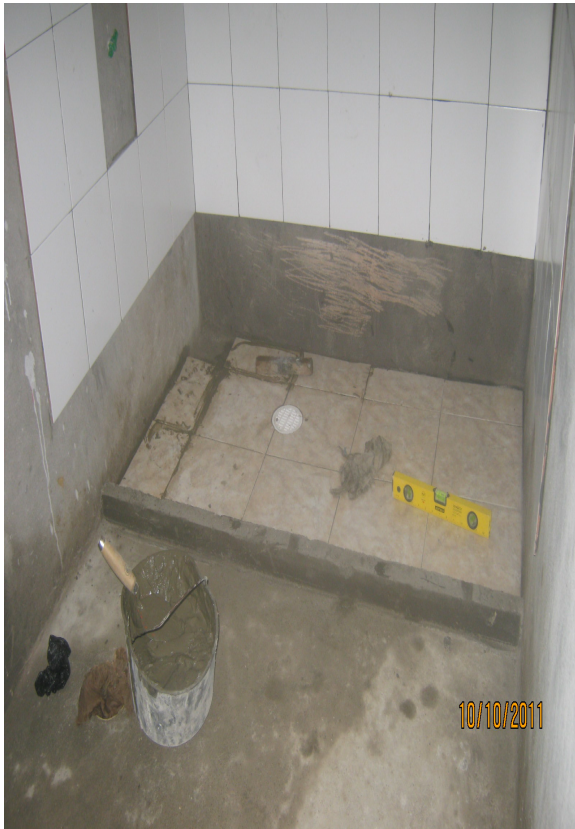
Figura 10. Enchape y obra terminada, mejoramiento 3
