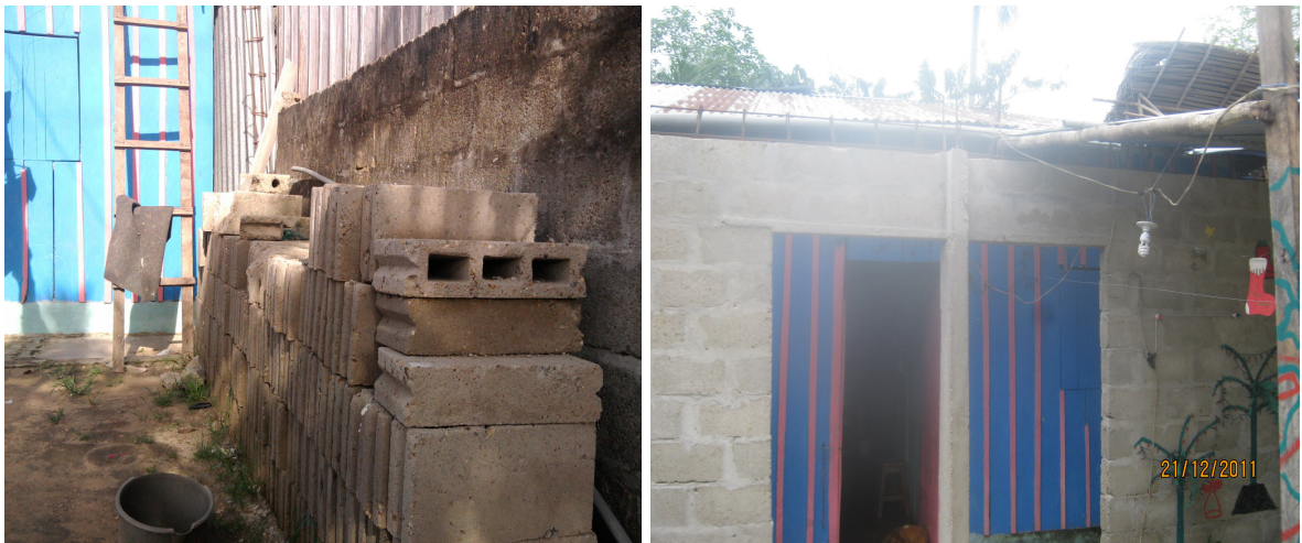
Figura 37. Visita preliminar, mejoramiento 16
