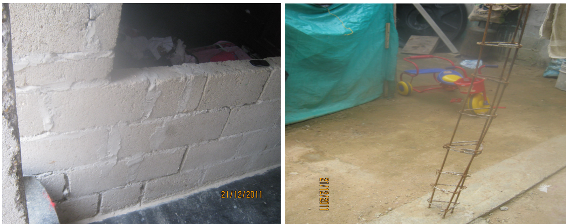
Figura 36. Divisiones y refuerzo de columnas, mejoramiento 15
