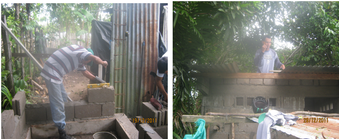
Figura 40. Muros divisorios y cubierta, mejoramiento 17
