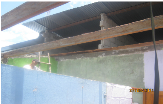
Figura 12. Vigas y obra terminada, mejoramiento 4
