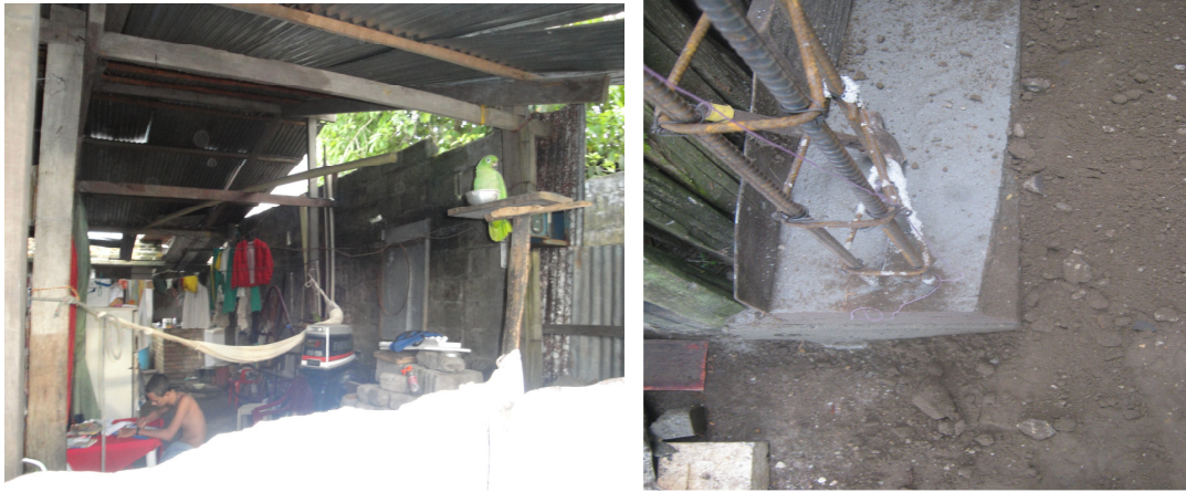
Figura 15. Visita preliminar y viga de cimentación, mejoramiento 6
