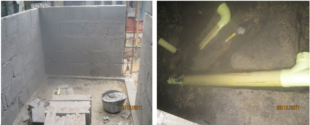
Figura 42. Muros divisorios y red sanitaria, mejoramiento 18
