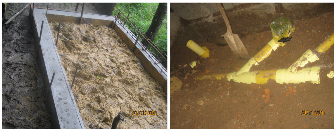
Figura 28. Viga de cimentación y red sanitaria, mejoramiento 12
