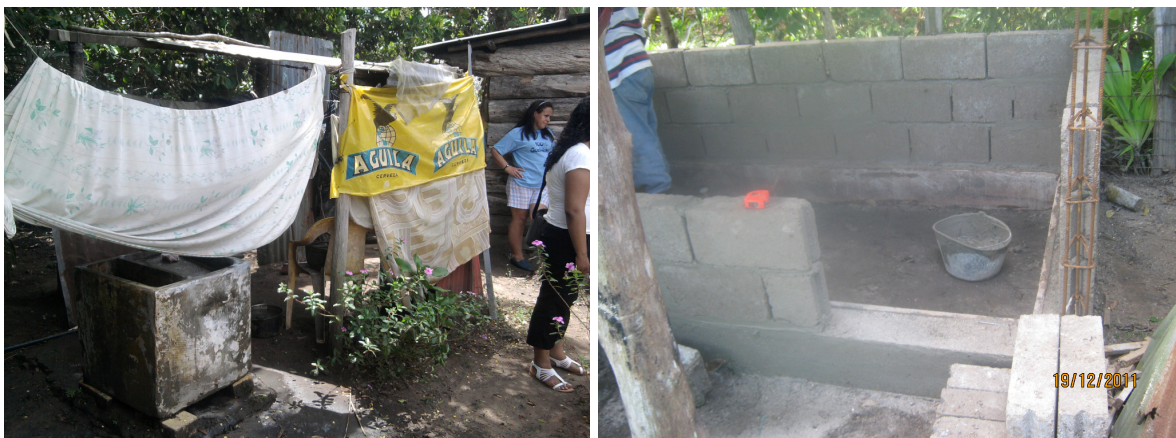
Figura 39. Visita preliminar y cerramiento, mejoramiento 17
