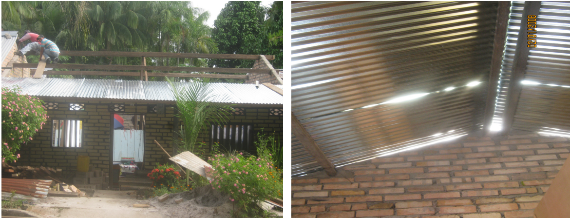
Figura 14. Cubierta y obra finalizada, mejoramiento 5
