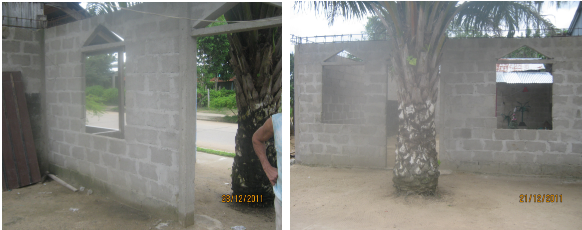
Figura 38. Muros divisorios, mejoramiento 16
