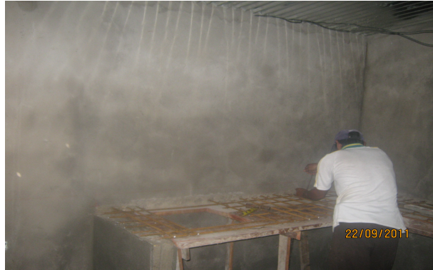
Figura 4. Refuerzo mesón, Mejoramiento 1
