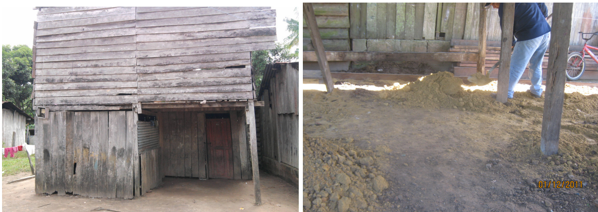
Figura 32. Visita preliminar y relleno, mejoramiento 14
