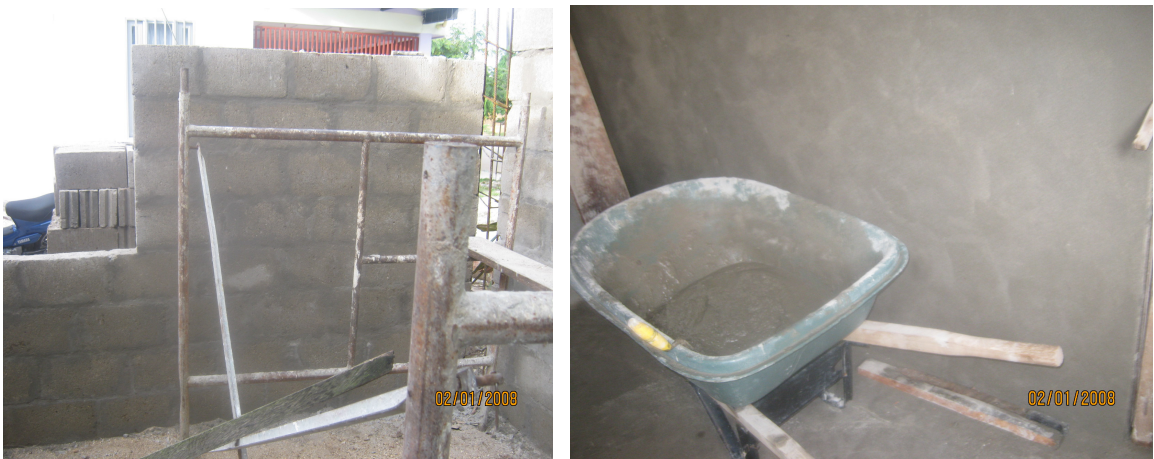
Figura 20. Muros y pañete, mejoramiento 8
