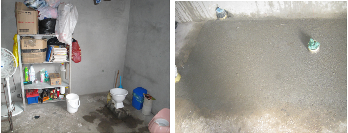
Figura 21. Visita preliminar y piso, mejoramiento 9
