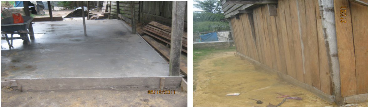
Figura 33. Piso y muro de madera, mejoramiento 14
