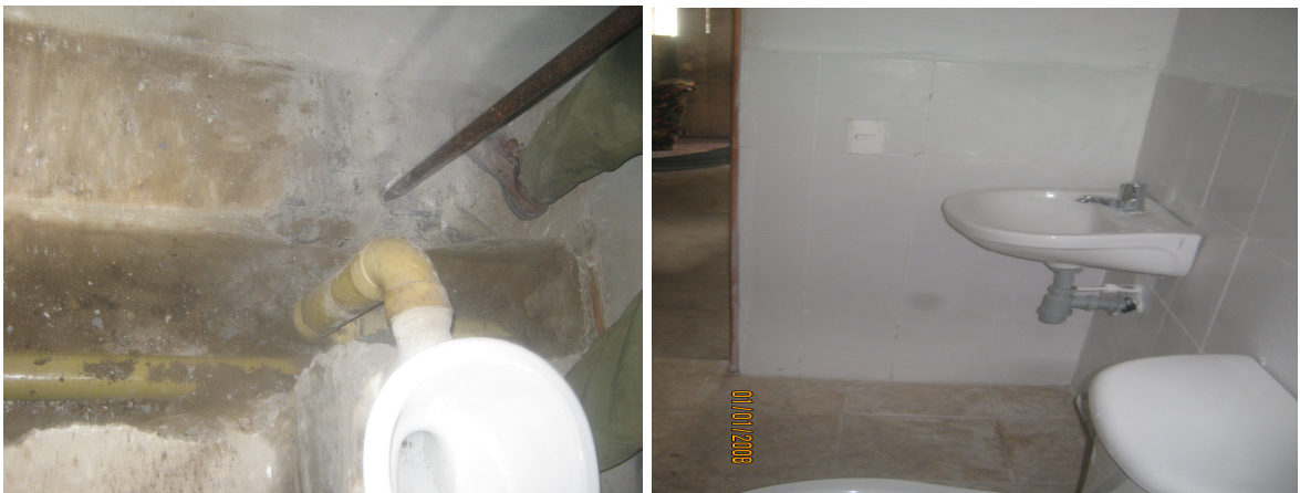
Figura 22 .Demoliciones y obra terminada, mejoramiento 9
