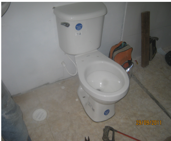
Figura 9. .Obra terminada, mejoramiento 2
