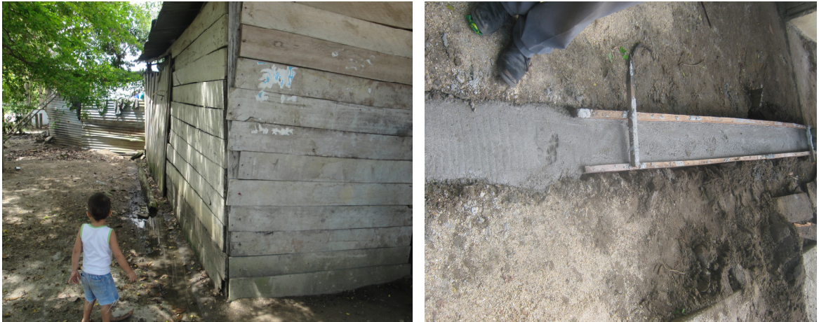
Figura 19. Visita preliminar y cimientos, mejoramiento 8
