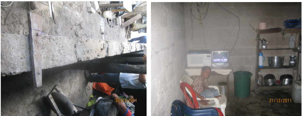
Figura 31. Muro y obra terminada, mejoramiento 13
