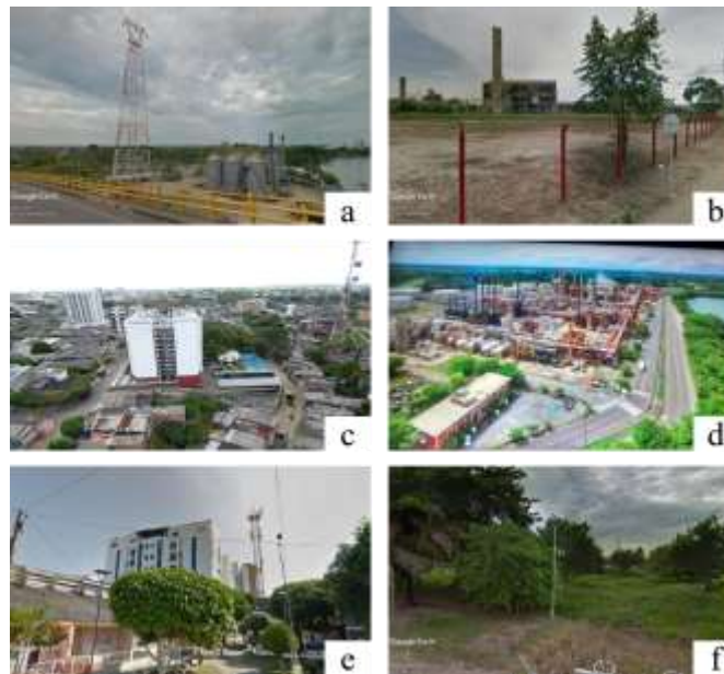
Figura 9. Sitios específicos con mayor cantidad de impacto de rayos en la ciudad de Barrancabermeja: (a) 5. Estructura de transmisión con 76 impactos, (b) 7. Urbanización (Fábrica) con 65 impactos, (c) 9. Torre de telecomunicación con 62 impactos, (d) 9. Refinería con 62 impactos, (e) 14. Hotel Super estrella con 46 impactos y (f) 16. Estructura de transmisión con 43 impactos.
