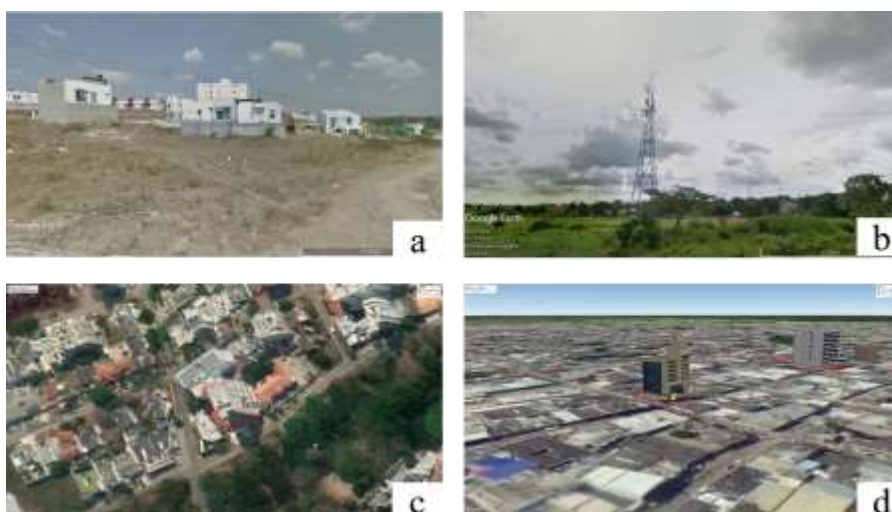
Figura 20. Sitios específicos con mayor cantidad de impacto de rayos en la ciudad de Sincelejo: (a) 1. Urbanización con 42 impactos, (b) 6. Estructura de Transmisión con 31 impactos (c) 5. Edificio Magenta con 32 impactos, (d) 7. Banco de Bogotá con 30 impactos.
