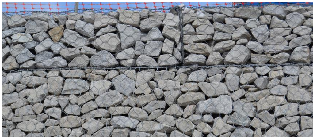
Figura 12. Muro en gavión
