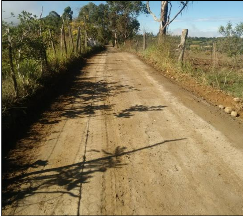
Figura 17. Tramo estabilizado.
