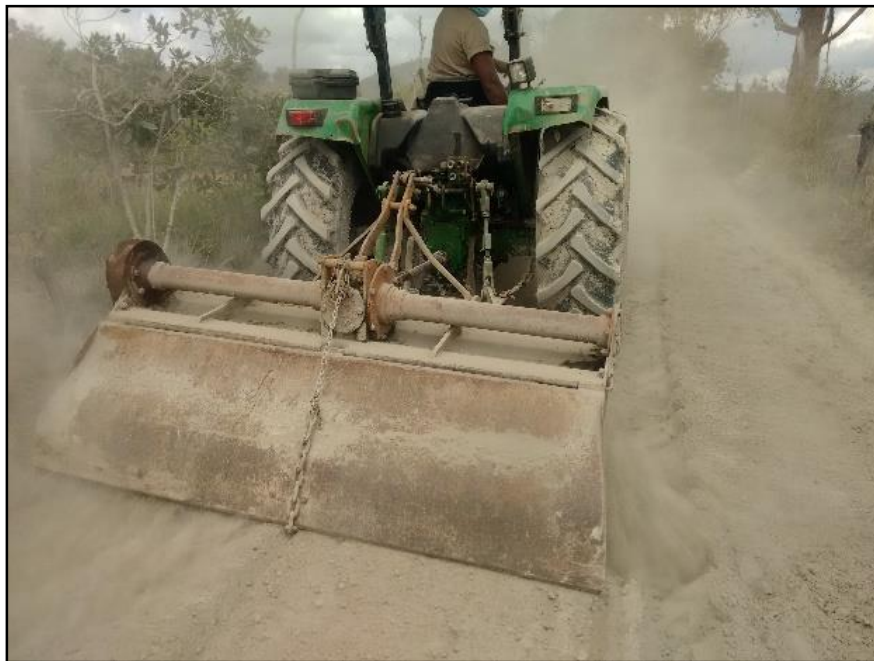
Figura 11. Mezcla del suelo y cemento con Rotavator.
