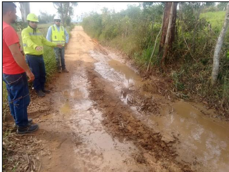
Figura 16. Zona más crítica debido a la acumulación de agua.
