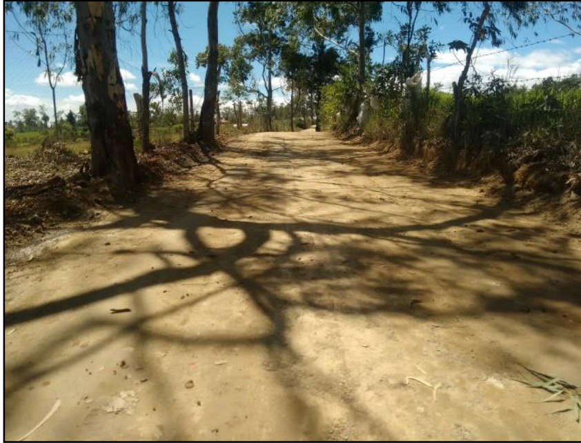
Figura 18. Zona crítica estabilizada.
