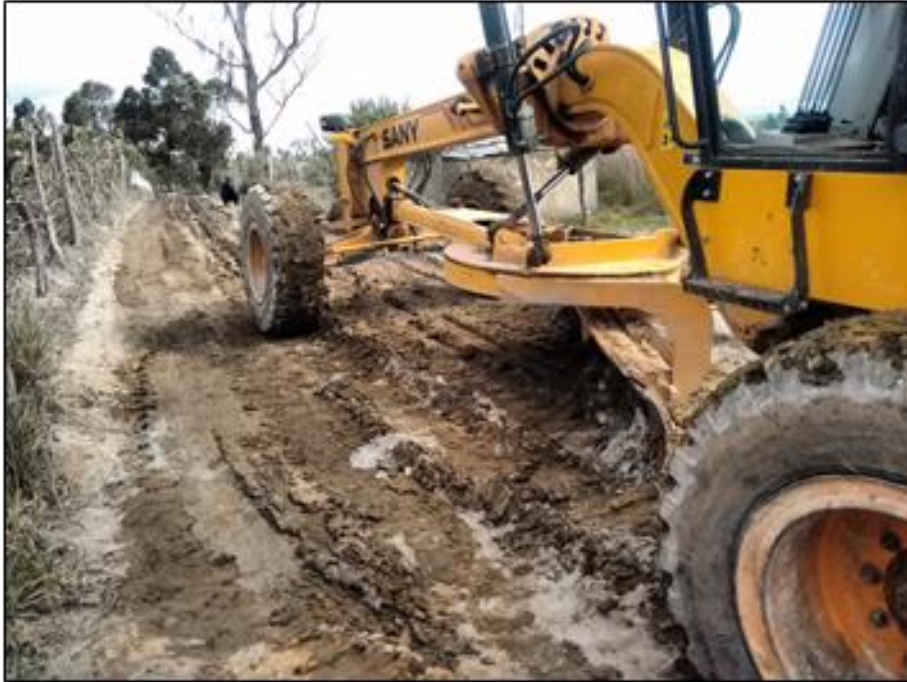
Figura 13. Conformación de la vía.
