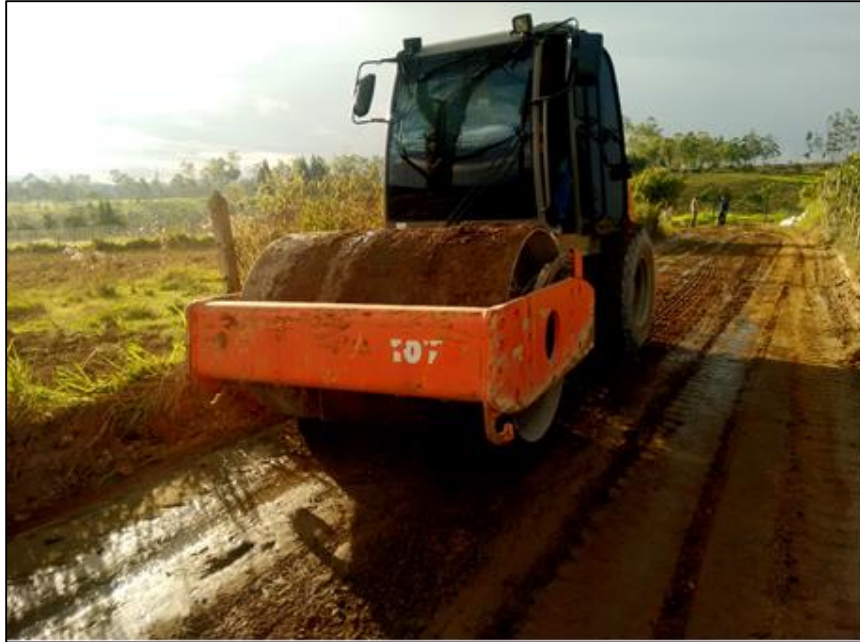
Figura 14. Compactación con vibro compactador.
