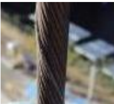
Figura 85. Armadura externa suelta
