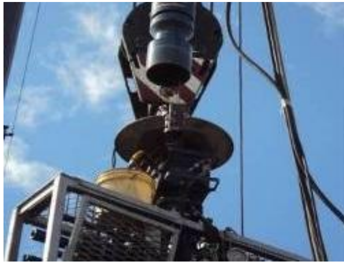
Figura 91. Plato instalado para sostener cable.
