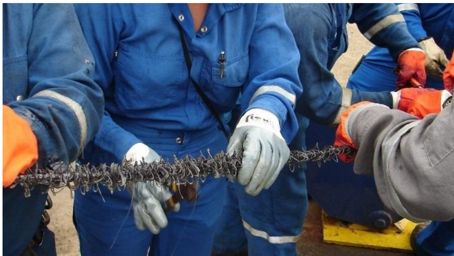
Figura 98. Corte de armadura externa.
