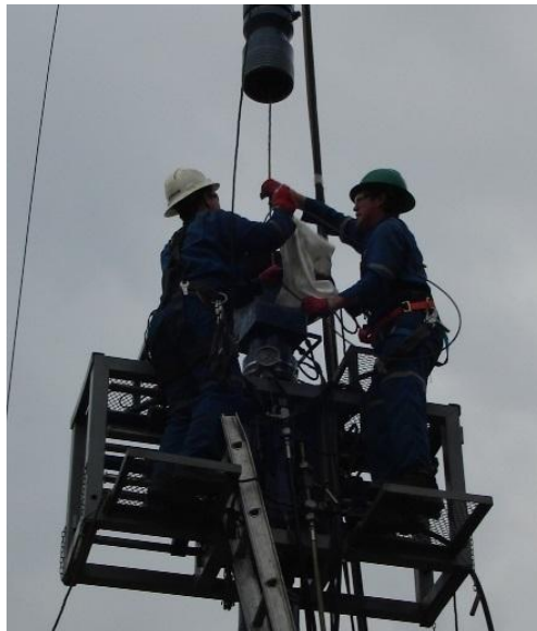
Figura 96. Desmontando lubricador
