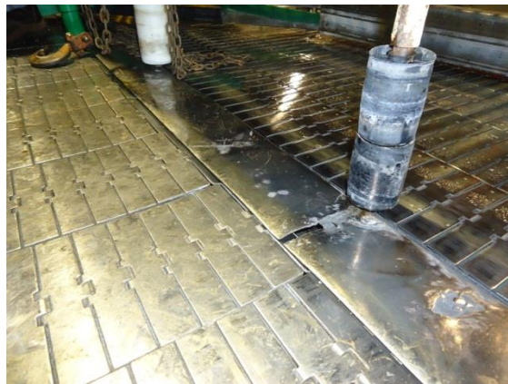
Figura 14. Zona de acumulación, plato de transferencia.
