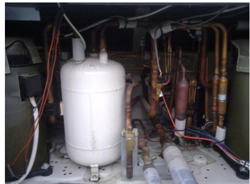
Figura 2. Accesorios en las líneas del refrigerante
