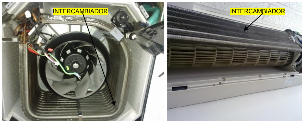
Figura 52. Intercambiador de calor de las evaporadoras
