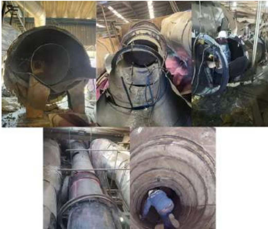
Figura 8. Implosión del Ducto
