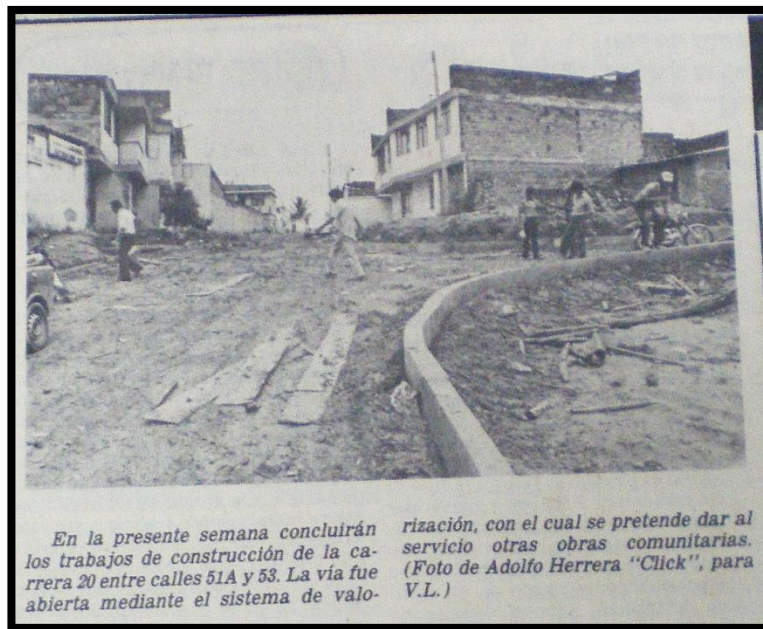
Fotografía 37. Ampliación de la Carrera 20 entre calle 51ª y 53
