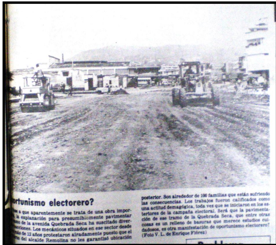
Fotografía 41. Rehabilitación de la Avenida Quebrada Seca
