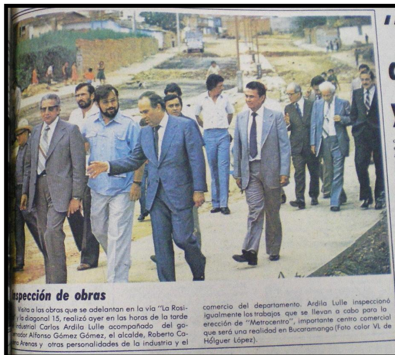
Fotografía 33. Inspección de Obras
