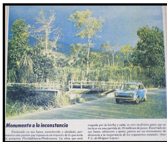
Fotografía 16. Deterioro de trabajos en la Autopista Floridablanca- Piedecuesta
