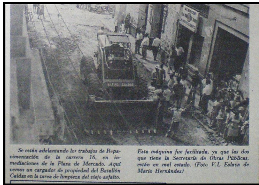
Fotografía 30. Repavimentación de la Carrera 16
