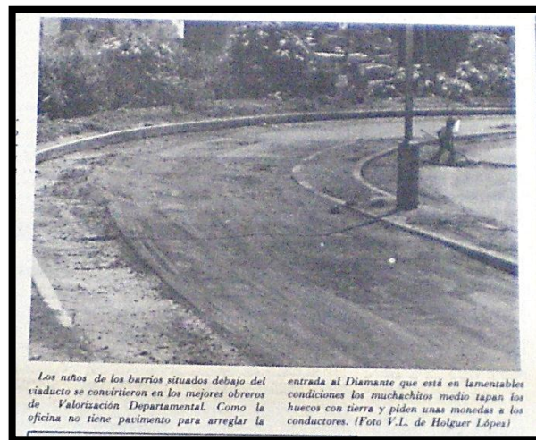
Fotografía 15. Mal estado de la vía al sector el Diamante
