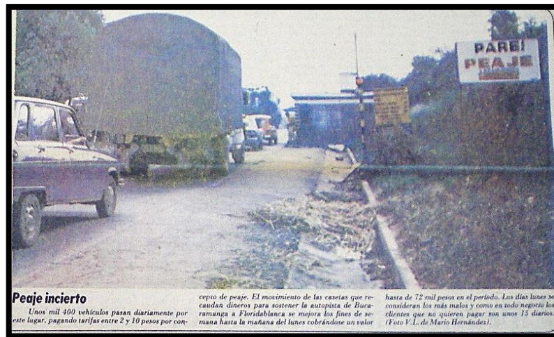
Fotografía 17. Mal estado del peaje Bucaramanga- Floridablanca
