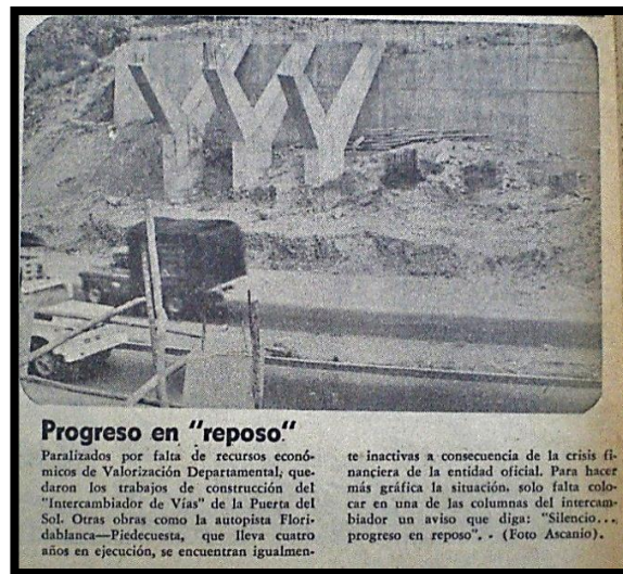
Fotografía 2. Intercambiador de la Puerta del Sol
