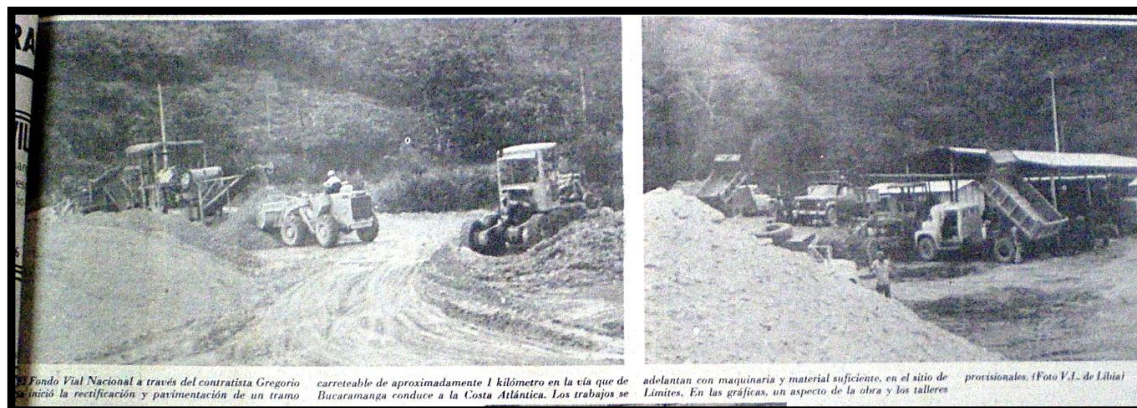
Fotografía 11. Pavimentación del tramo carreteable Bucaramanga- Costa Atlántica
