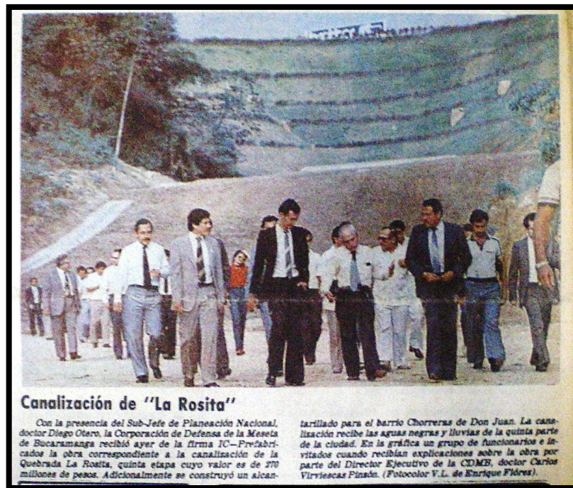
Fotografía 40. Canalización de la Quebrada La Rosita
