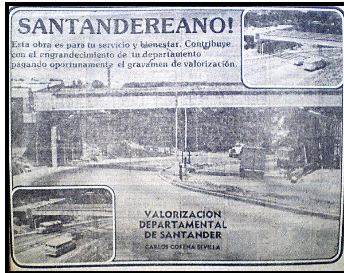
Fotografía 7. Avances en el Intercambiador de la Puerta del Sol
