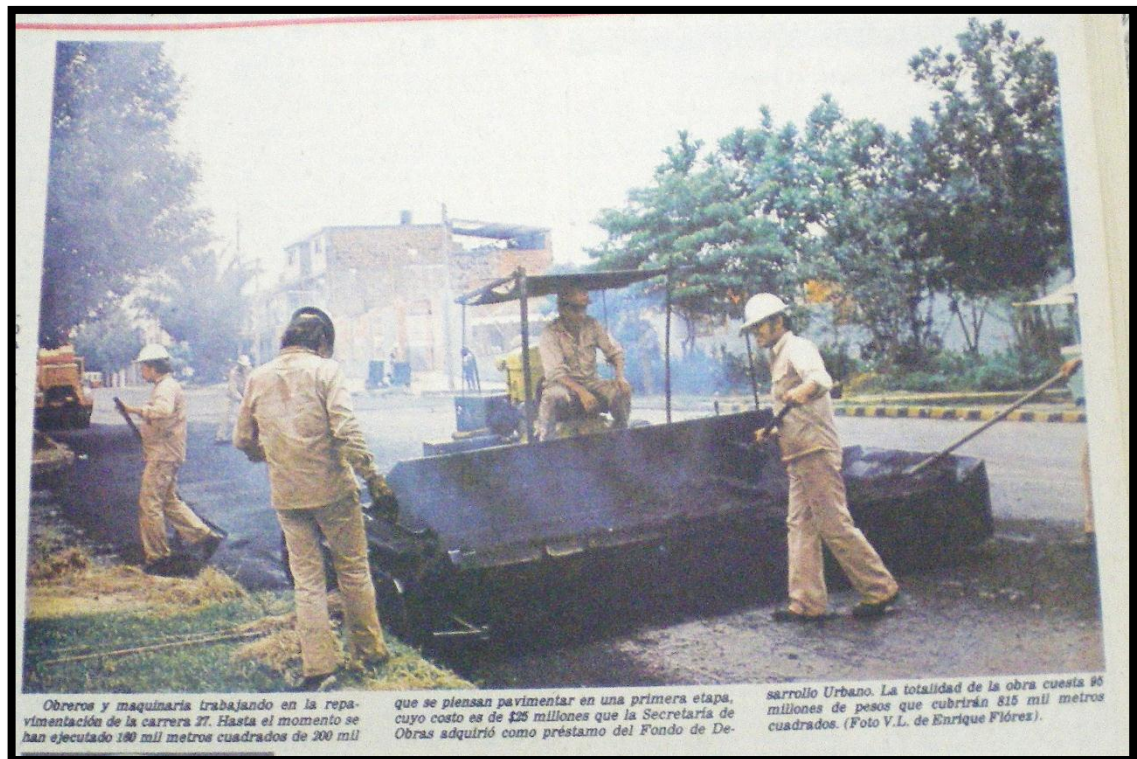
Fotografía 39. Repavimentación de la Carrera 27
