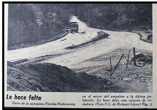
Fotografía 12. Trabajos faltantes en la Autopista Floridablanca- Piedecuesta
