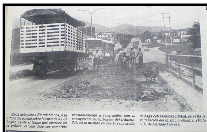
Fotografía 19. Rehabilitación de la Autopista de Floridablanca a la altura del barrio Lagos
