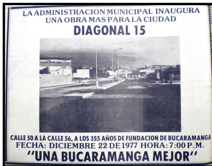
Fotografía 27. Entrega de la primera etapa de la Diagonal 15
