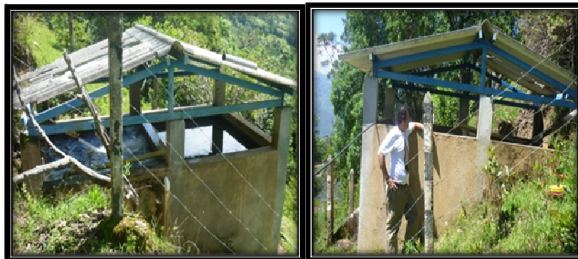
Fotografía 19 y 20. Desarenador
