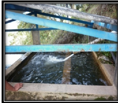
Fotografía 8. Desarenador
