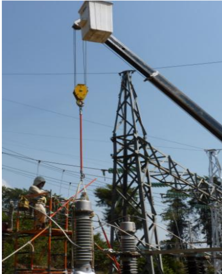
Figura 22. Grúa levantando el PT
