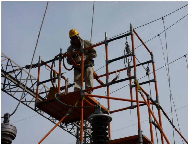
Figura 15. Andamio para trabajo en línea viva
