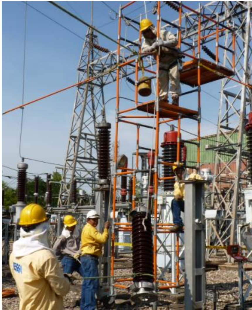
Figura 21. Desmonte de pararrayos
