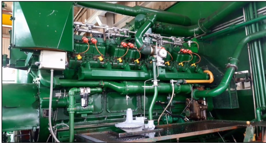
Figura 21. Motor Caterpillar G-399
