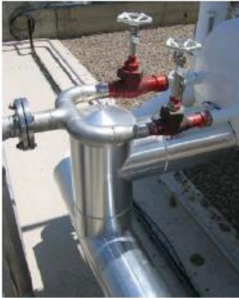
Figura 41. Válvulas criogénicas mixtas de maniobra manual y de anti-retorno.
