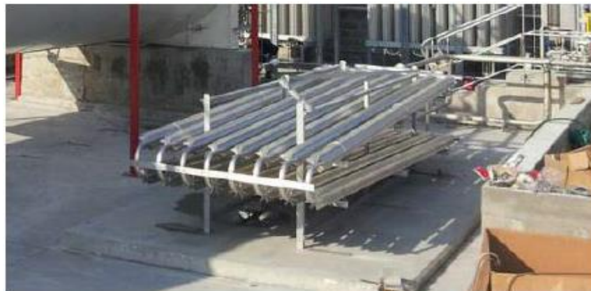
Figura 42. Regasificador PPR.
