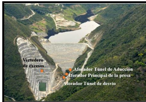
Figura 13. Vertederos triangulares instalados para medición de infiltraciones
