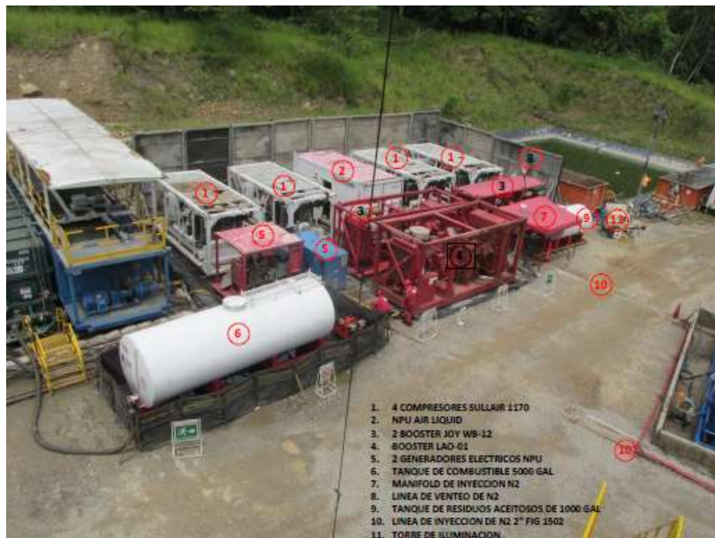
Figura. 39. Rig Up de Equipo de compresión e inyección de Nitrógeno
