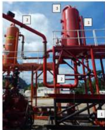
Figura. 38. Rig Up de Separador atmosférico de 2 fases
