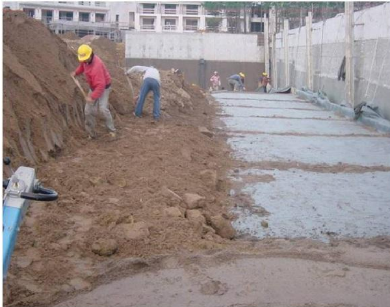
Fotografía 6 : Distribución de material de relleno
