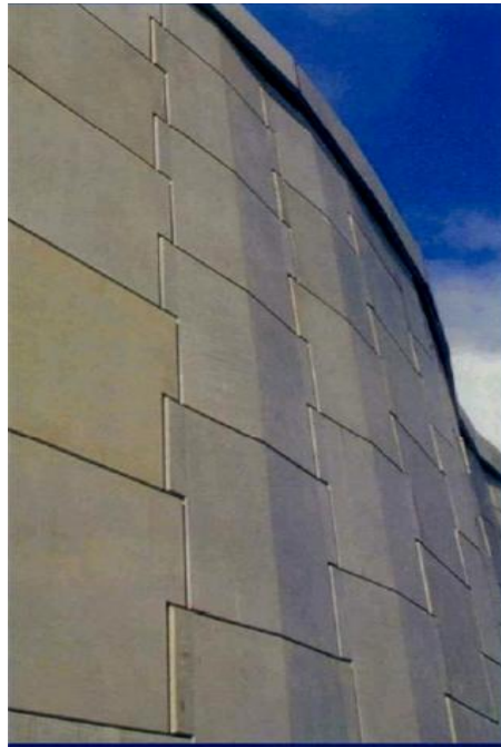
Fotografía 10 : Fachadas de muro de contención de tierra mecánicamente estabilizada
