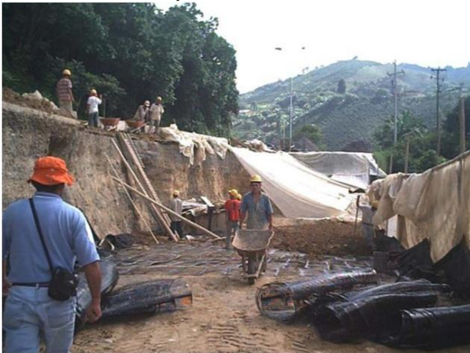
Fotografía 3 : Construcción de drenajes
