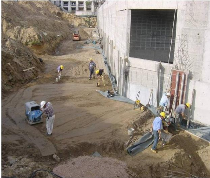
Fotografía 7 : Compactación material de relleno
