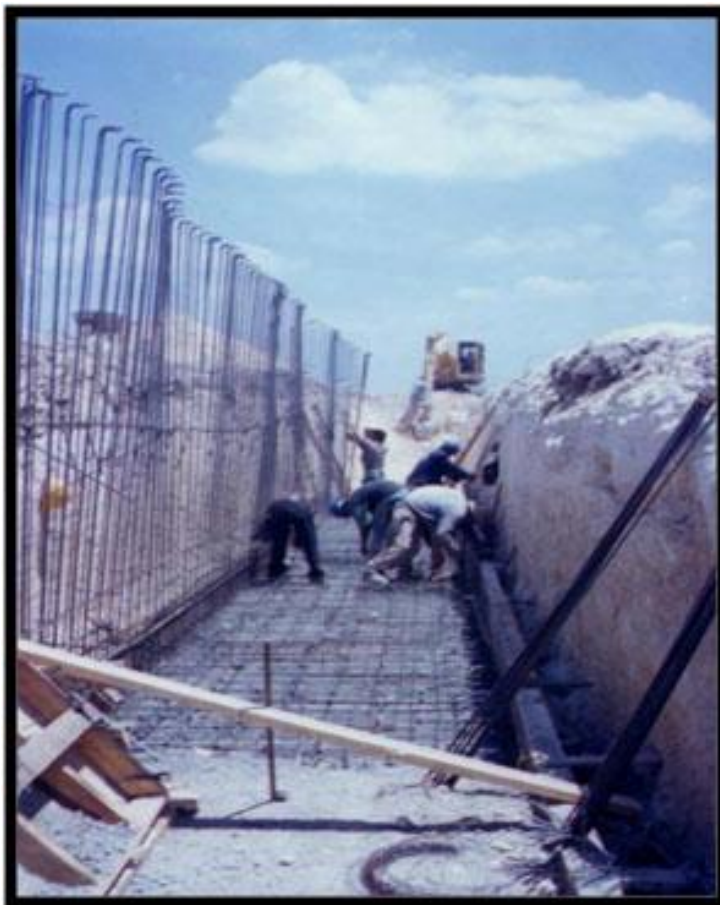
Fotografía 12 : Colocación del refuerzo en muro de contención de concreto reforzado
