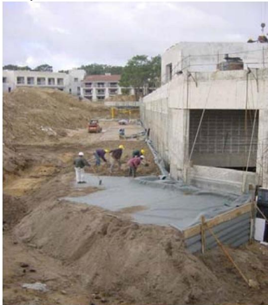
Fotografía 8 : Construcción de capas en muro de tierra mecánicamente estabilizada
