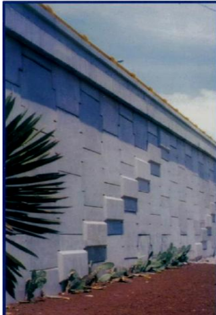
Fotografía 9 : Fachadas de muro de contención de tierra mecánicamente estabilizada
