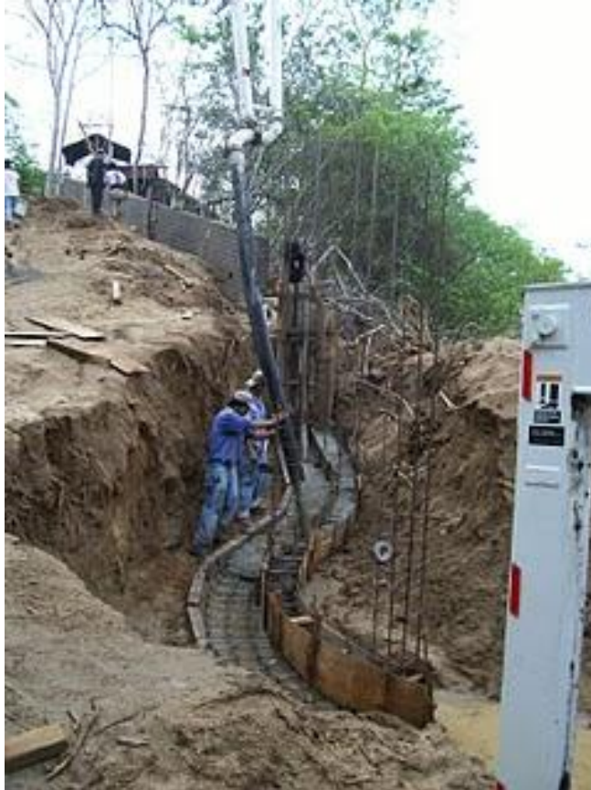
Fotografía 13 : Preparación para vaciado de concreto de cimientos
