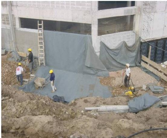
Fotografía 4 : Colocación del geosintético
