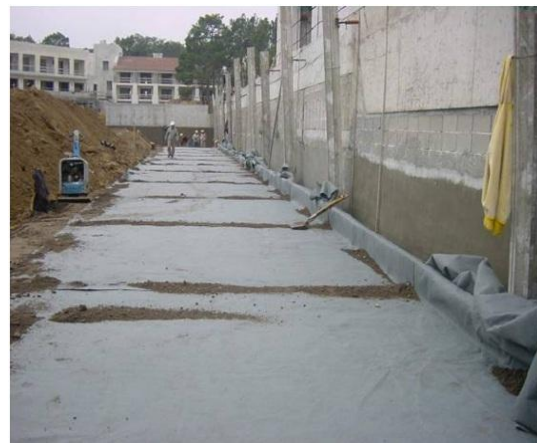
Fotografía 5 : Distribución del geosintético
