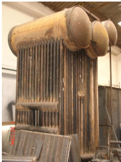
Figura 22. Construcción de la caldera
