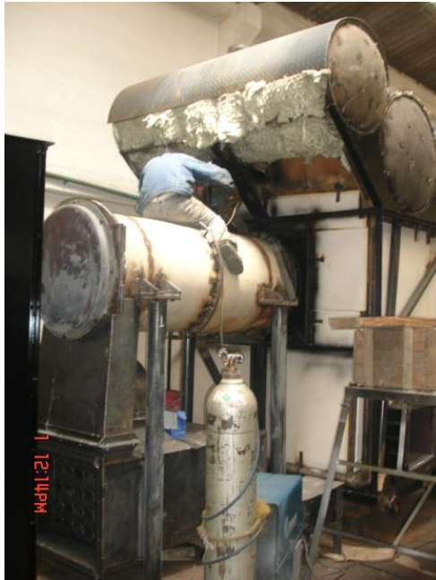
Figura 25. Refractarios y aislantes térmicos usados en la caldera
