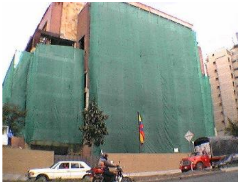
Figura 3. Fotografía de un edificio en construcción con el uso de la Malla Constructex
