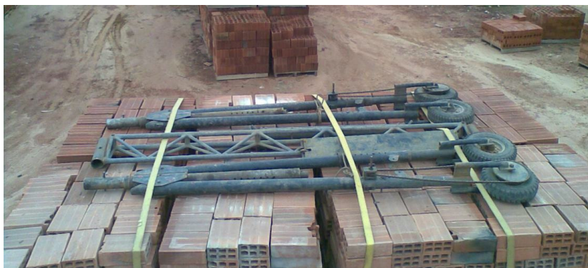
Figura 87. Elementos asegurados sobre las estibas en el camión.
