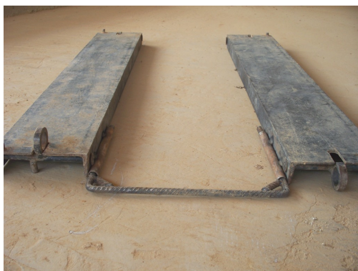
Figura 79. Montaje del sistema de separación de las paletas inferiores.
