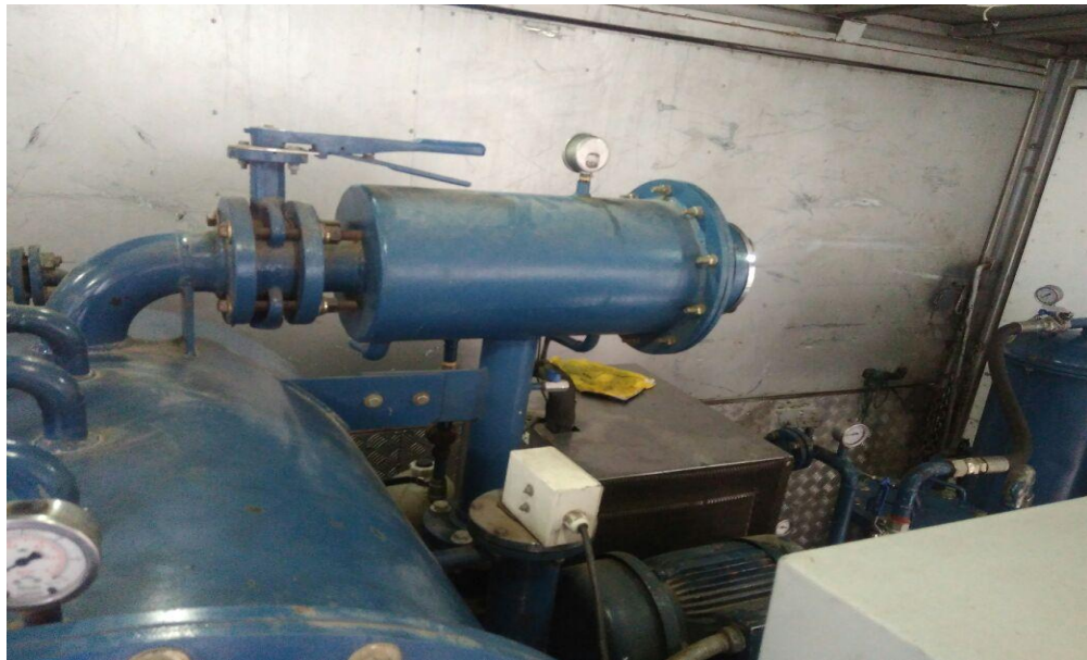
Anexo D: Salida de Cámara de vacío.
