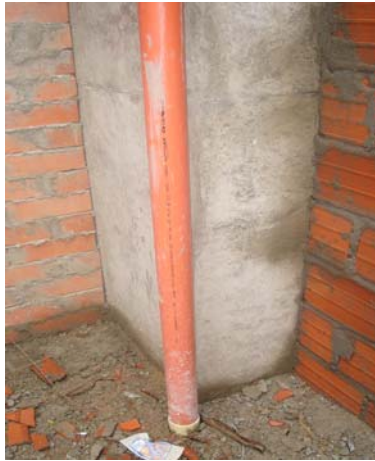
Figura 3.4. Ejemplos de tuberías verticales pegada a un elemento estructural.
