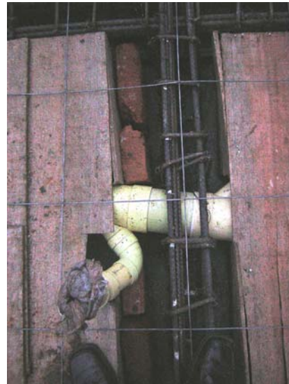
Figura 3.7. Ejemplos de viguetas atravesadas transversalmente por una tubería horizontal.
