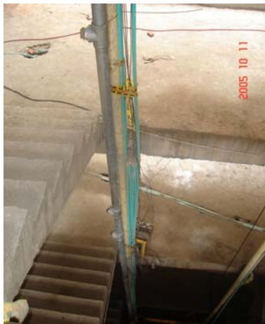
Figura 3.3. Ejemplos de tuberías verticales a través de los espacios de las escaleras en una edificación.
