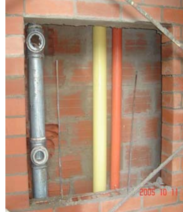
Figura 3.2. Ejemplos de tuberías verticales por medio de sistemas de aberturas de placa.
