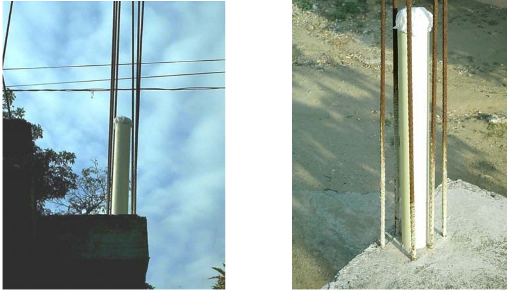
Figura 3.6. Ejemplo de tuberías embebidas en columnas.
