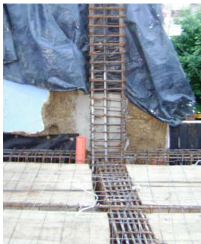
Figura 3.5. Ejemplo de tuberías embebidas en vigas.
