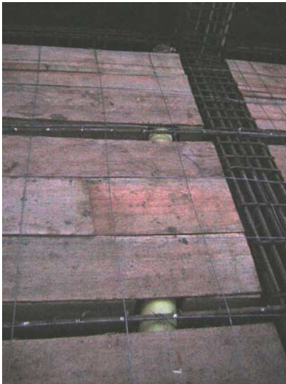
Figura 3.7. Ejemplos de viguetas atravesadas transversalmente por una tubería horizontal.
