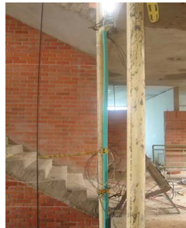
Figura 3.3. Ejemplos de tuberías verticales a través de los espacios de las escaleras en una edificación.
