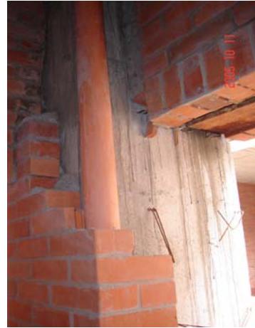
Figura 3.4. Ejemplos de tuberías verticales pegada a un elemento estructural.
