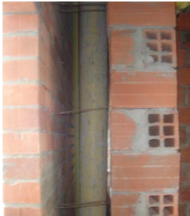
Figura 3.2. Ejemplos de tuberías verticales por medio de sistemas de aberturas de placa.
