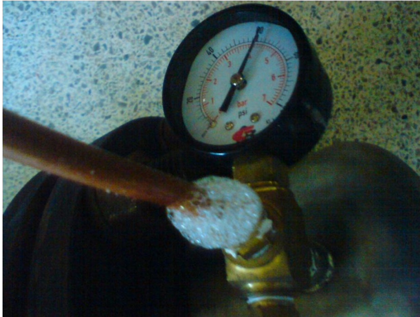
Figura 48. Prueba de detección de fugas
