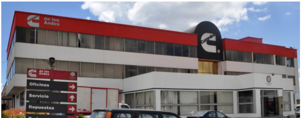
Imagen 03. Instalaciones Equitel Bogotá
