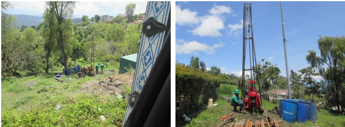
Figura 43. Vista general de sondeos.
