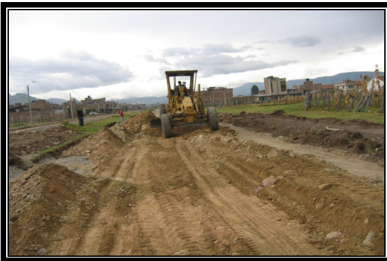
EXTENDIDO SEGUNDA CAPA DE SUB-BASE CALZADA OCCIDENTAL
