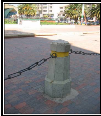
Fotografía 6. Bolardos de seguridad
