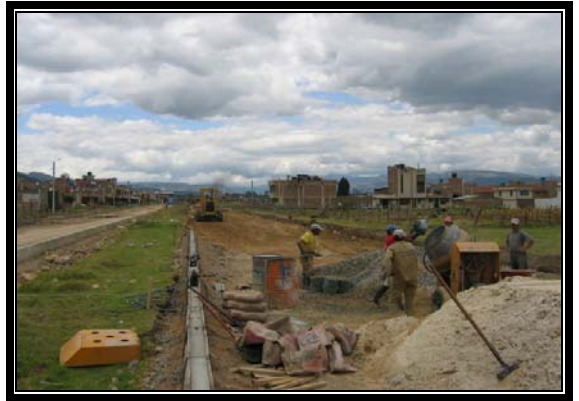
FUNDICION DE SARDINELES COSTADO OCCIDENTAL
