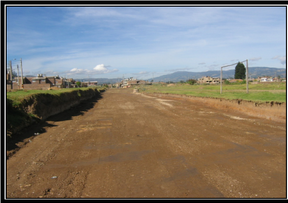
COTA SUB-RAZANTE DE CALZADA OCCIDENTAL (Condiciones iniciales)
