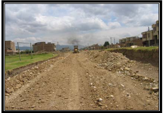
COLOCACION Y EXTENDIDO DE SUBBASE GRANULAR COSTADO OCCIDENTAL
