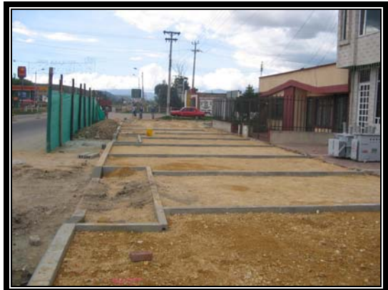
COLOCACION DE UNIDADES DE CONFINAMIENTO Y ARENA DE NIVELACION
