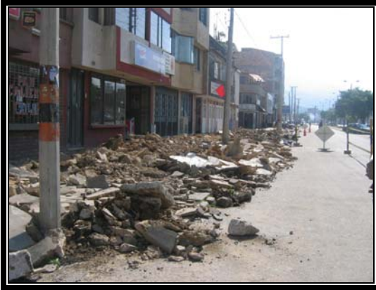
DEMOLICIÓN Y RETIRO DE ANDENES EXISTENTES
