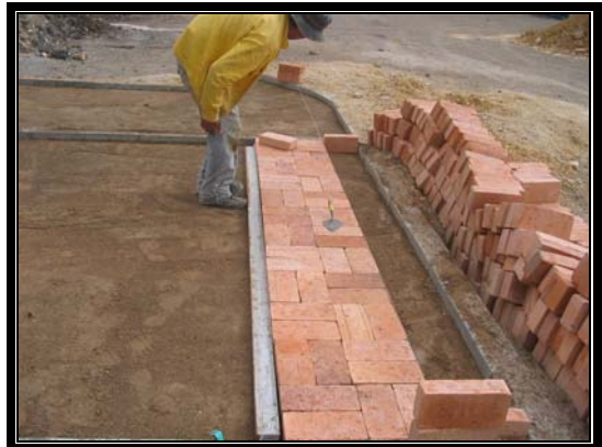
NIVELACION Y COLOCACION DE ADOQUIN COLONIAL PEATONAL
