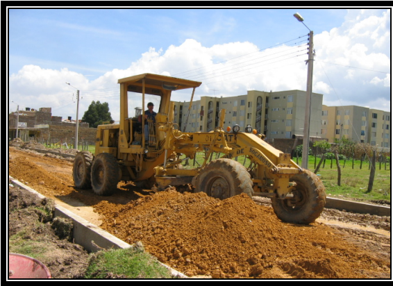
EXTENDIDO DE BASE GRANULAR CALZADA ORIENTAL
