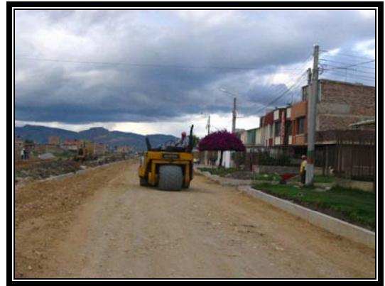
COMPACTACION BASE GRANULAR COSTADO ORIENTAL
