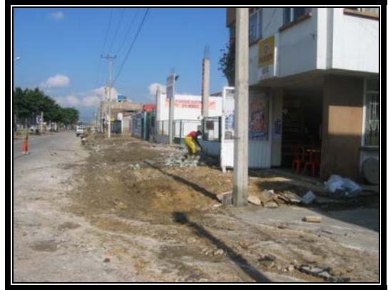
DEMOLICIÓN Y RETIRO DE ANDENES EXISTENTES
