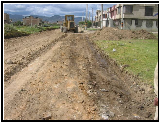
Fotografía 2. Eliminación material superficial
