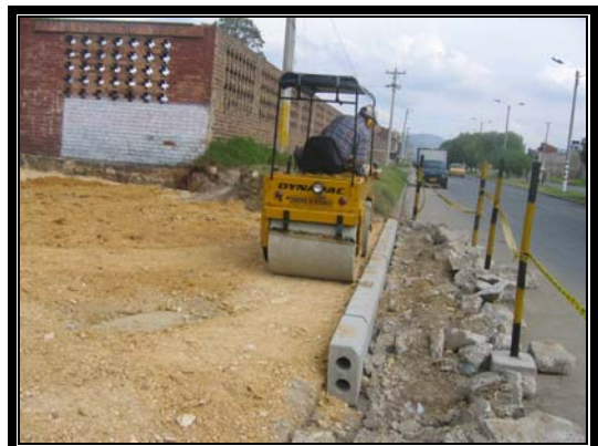
CONSTRUCCION DE SARDINEL DE CONFINAMIENTO PREFABRICADO Y COMPACTACION DE BASE.
