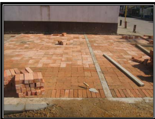
NIVELACION Y COLOCACION DE ADOQUIN COLONIAL PEATONAL
