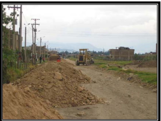
PUESTA EN SITIO DE SUB-BASE GRANULAR
