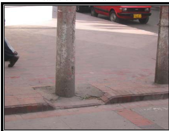
Poste sobre rampa
