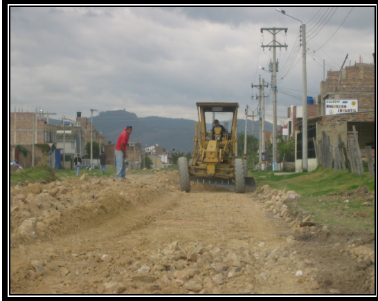
EXTENDIDO DE SUB-BASE GRANULAR
