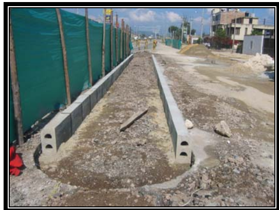
CONSTRUCCIÓN SEPARADOR (1.20m) BASE COMPACTADA Y BORDILLO PREFABRACADO
