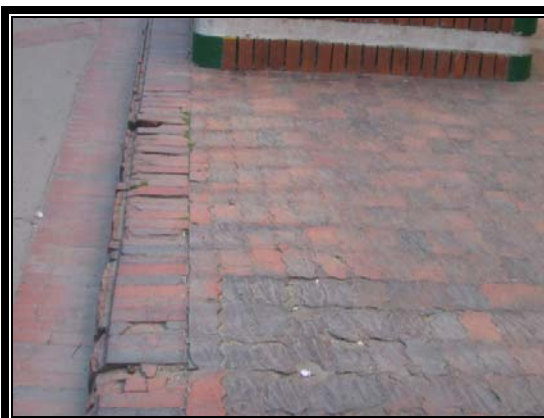
Sobre cargas en andén por invasión vehicular
