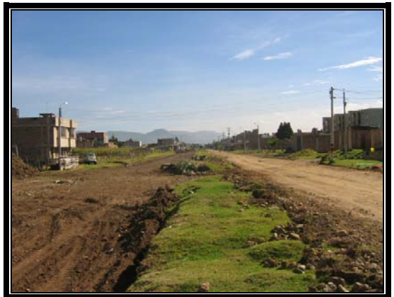
ESCARIFICACION Y ELIMINACION DE CAPA VEGETAL
