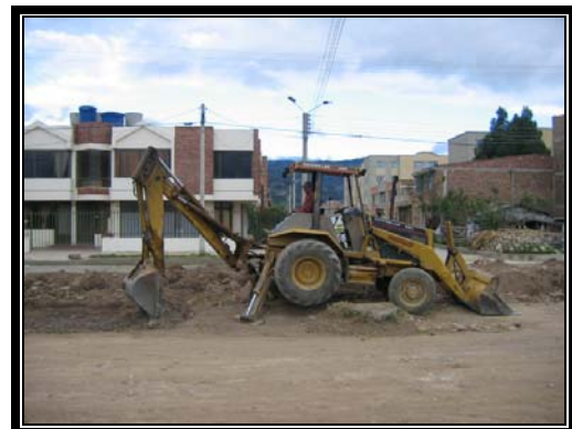
EXCAVACION DEL SEPARADOR
