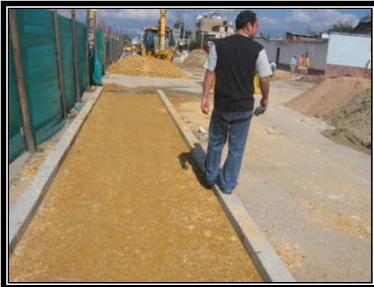
CONSTRUCCIÓN SEPARADOR (1.20m) BASE COMPACTADA Y BORDILLO PREFABRACADO
