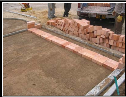
COLOCACION DE UNIDADES DE CONFINAMIENTO Y ARENA DE NIVELACION
