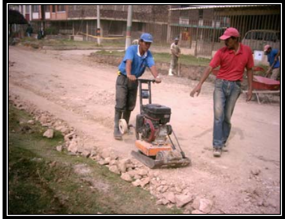
ALISTADO Y COMPACTACION PARA BASE DE SARDINEL
