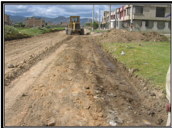
EXCAVACION Y PERFILADO DE LA CALZADA ORIENTAL
