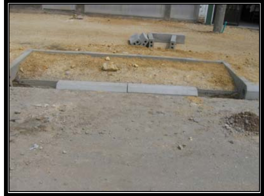
CONSTRUCCION RAMPASCE ACCESO VEHICULOS Y DICAPACITADOS
