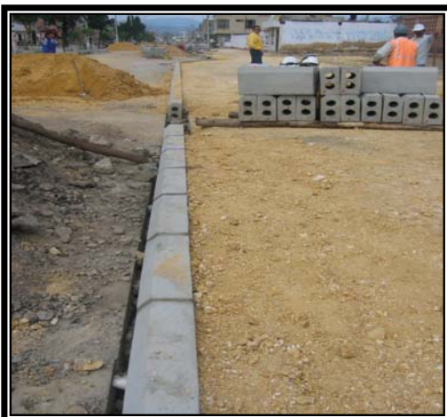
CONSTRUCCION DE SARDINEL DE CONFINAMIENTO PREFABRICADO Y COMPACTACION DE BASE.
