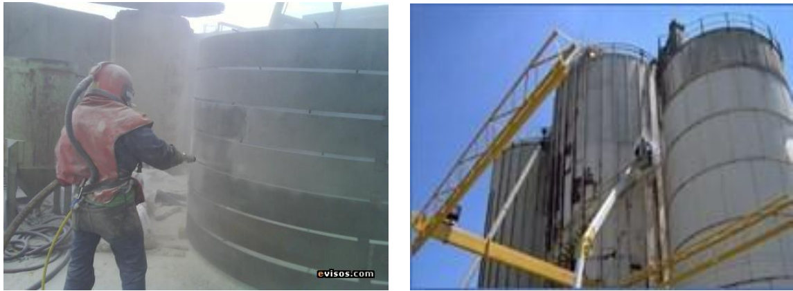
Foto 1. Limpieza con sandblasting
