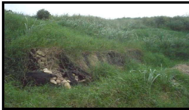
Figura 22. Muro de Gaviones. Relleno Sanitario El Carrasco.
