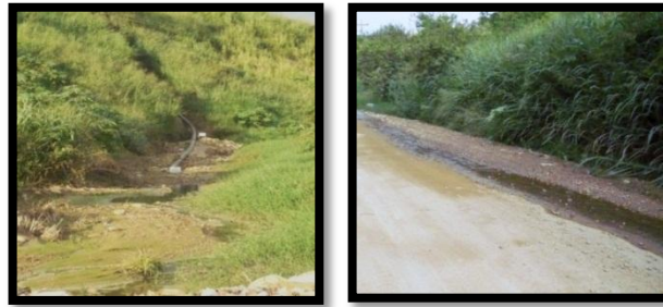
Figura 17. Vertimiento de Lixiviados. Relleno Sanitario El Carrasco.
