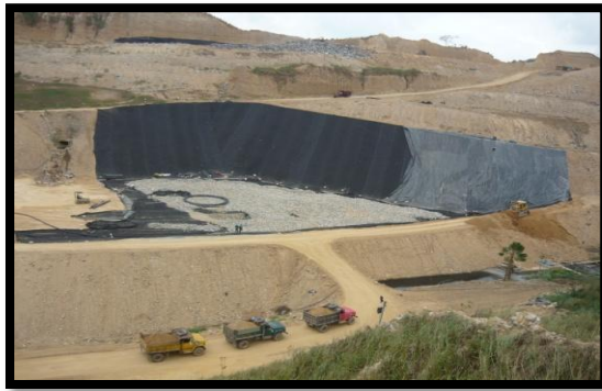
Figura 9. Método Combinación de Área y Rampa. Relleno Sanitario El Carrasco.
