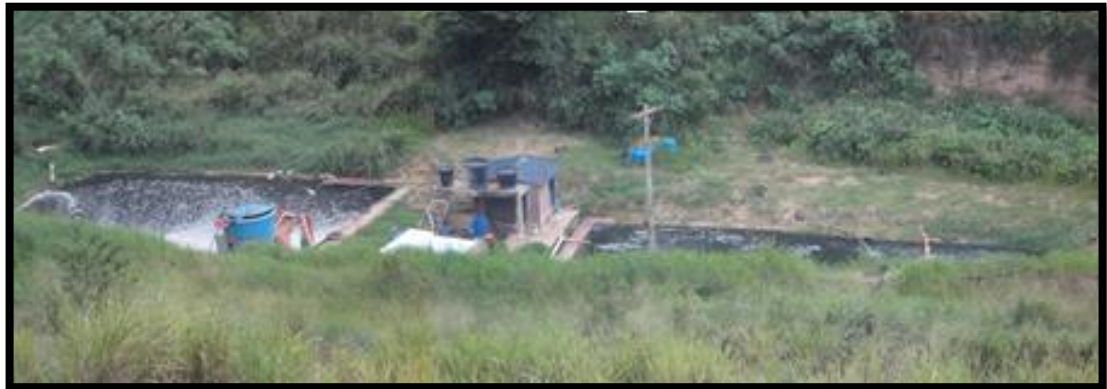
Figura 18. Planta de Tratamiento de Lixiviados. Relleno Sanitario El Carrasco.
