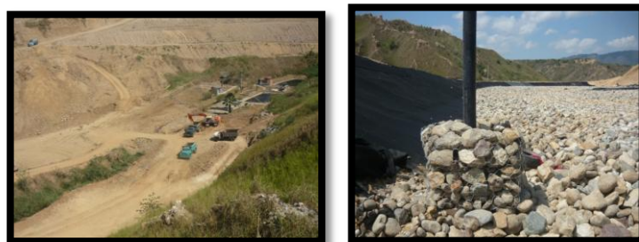
Figura 8. Método Combinado de Área y Rampa. Relleno Sanitario El Carrasco.
