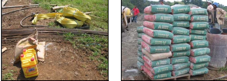
Figura 4. Sika Top 122, varillas corrugadas de \varnothing = \frac{1}{2} ", cinta Sika PVC O-22, y Cemento
