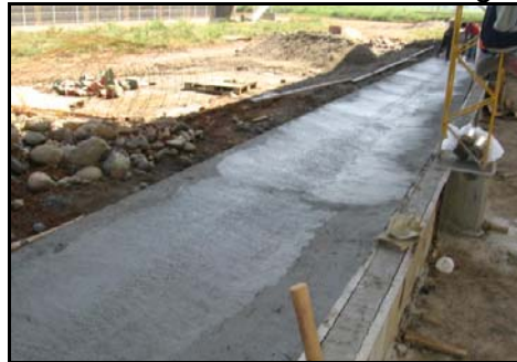
Figura 17. Aplicación mortero de resane sobre canaleta desgastada
