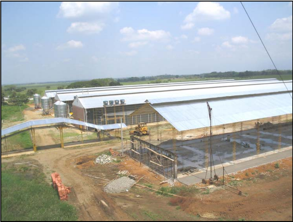
Anexo G. Zona de construcción de los galpones de producción
