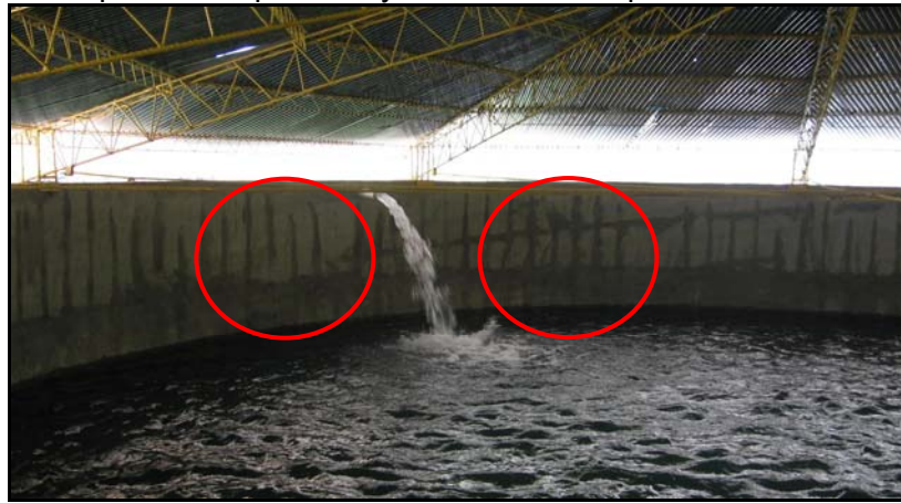
Figura 6. Detalle de paredes reparadas y llenado del tanque
