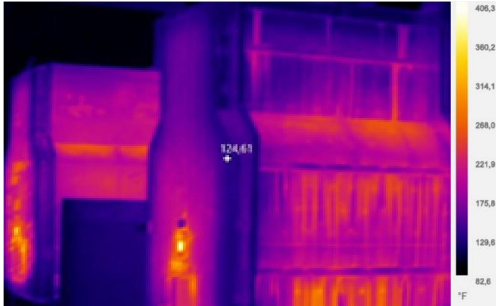
Apéndice A. Termografía lateral de los dos hornos.
