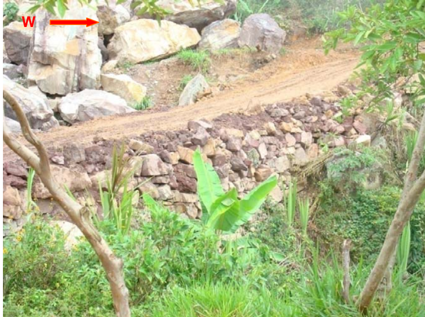
Foto 33. Construcción del tramo de vía. Fuente: Investigación de los Autores, 2008.
