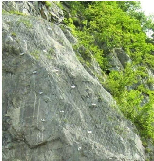
Foto 46 Anclaje del cable espiral con el perimetral y conexiones de clavos pequeños. Fuente: http://www.geobrugg.com
