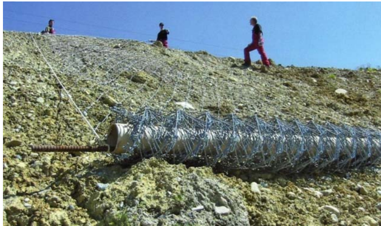
Foto 47. Rollo del sistema de protección de rocas Fuente: http://www.geobrugg.com
