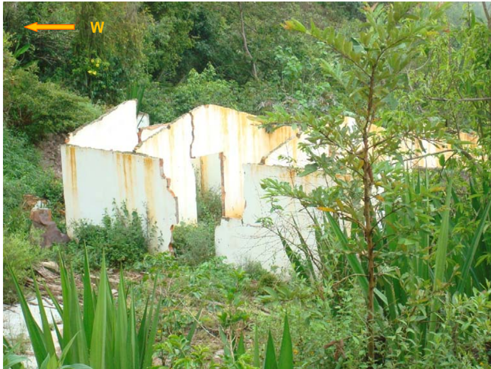
Foto 34. Casa en ruinas. Fuente: Investigación de los Autores, 2008.
