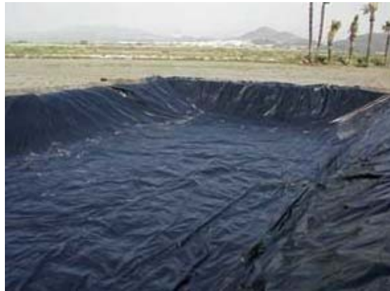
Foto 45. Proceso de colocación de Geomembrana. Fuente: http://www.projar.es/imag/xm/xm3/embalik.jpg
