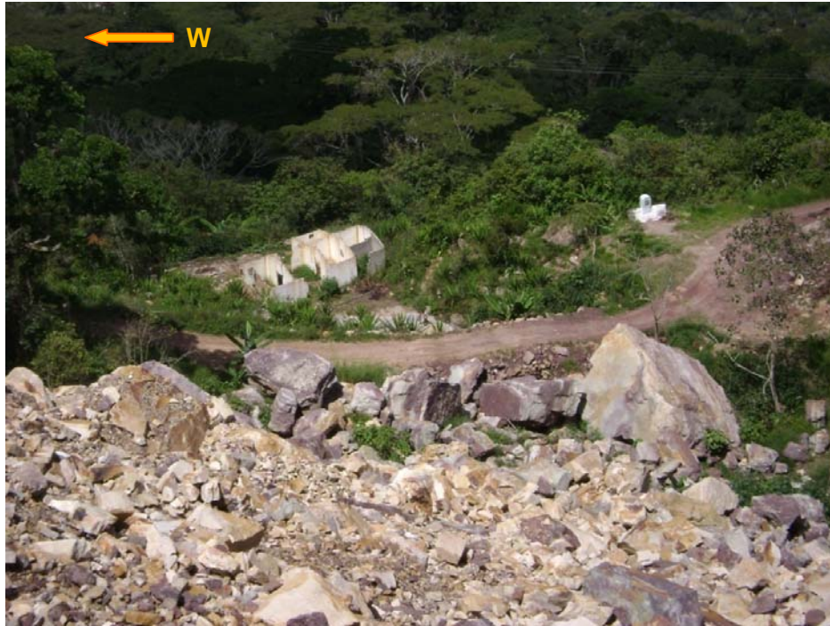
Foto 30. Caídos del Deslizamiento en estudio, Vereda El Palmar, Aratoca Santander. Imagen tomada desde el BM1 Fuente: Investigación de los Autores, 2008.
