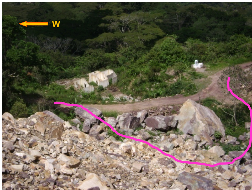
Foto 32. Casa destruida. La línea en color indica la ruta de la antigua vía. Imagen tomada desde el BM 3 (1232482.74N; 1115362.61E). Fuente: Investigación de los Autores, 2008.
