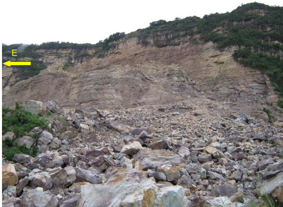
Foto 5. Costado izquierdo del deslizamiento. Imagen tomada desde BM1 Fuente: Investigación de los autores, 2008.
