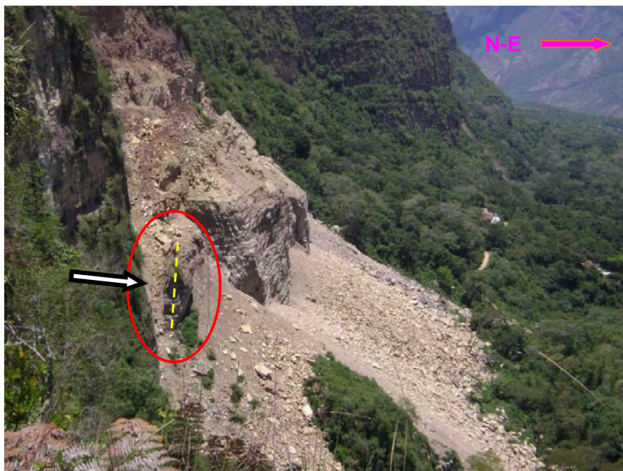
Foto 23. Movimiento de un bloque 1 del talud en estudio, abril 30. Imagen tomada desde el BM 2 (1232364N; 1115847E). Fuente: Investigación de los autores, 2008.
