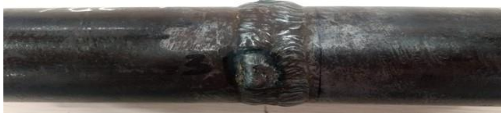
Figura 120. Tubería de inspección de soldadura punto 3.
