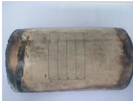
Figura 28. Tubería N°1. Para análisis de pérdida de espesor
