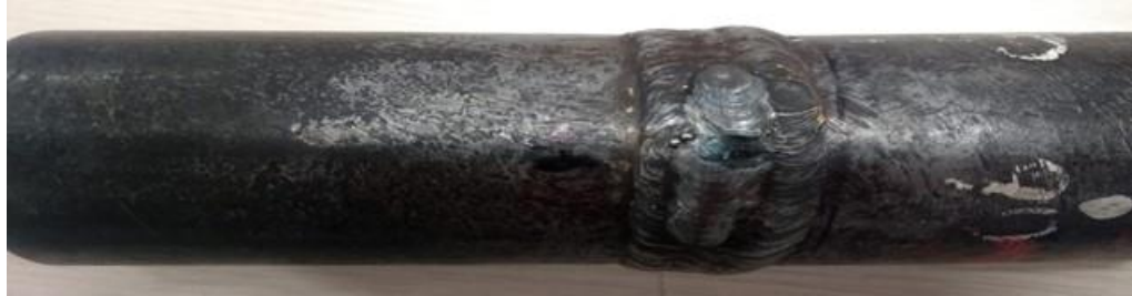
Figura 110. Tubería de inspección de soldadura punto 1.
