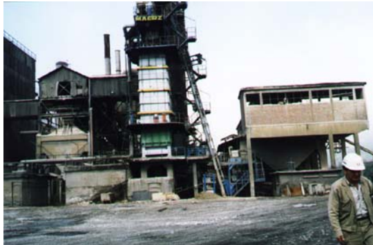
Figura 6. Sección de Calcinación
